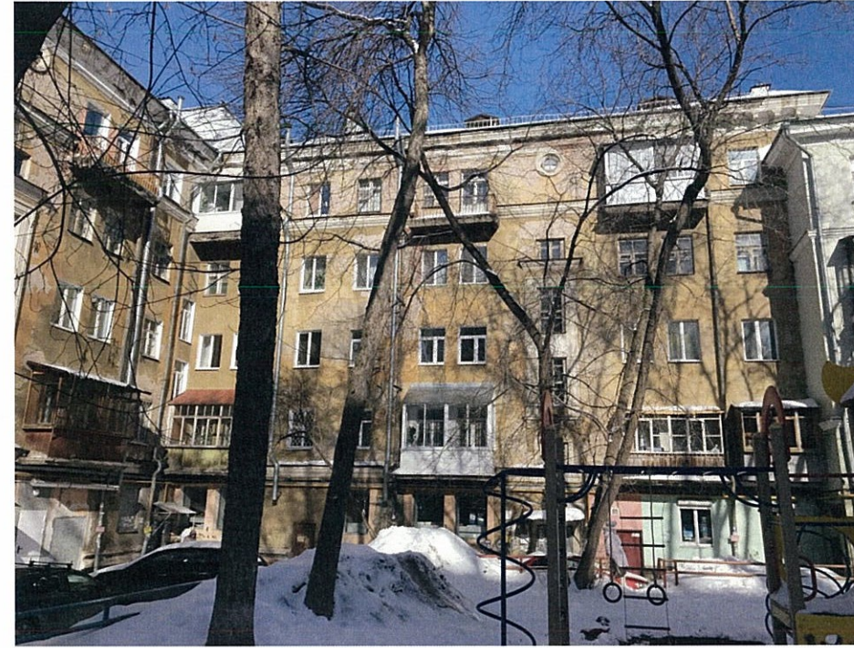
Существующее состояние дворового фасада (фотофиксация).
