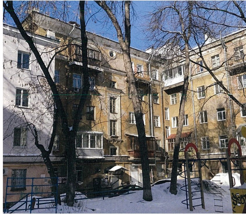
Существующее состояние дворового фасада (фотофиксация).
