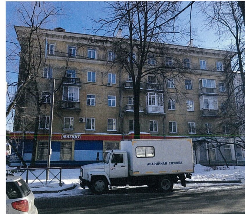
Существующее состояние главного фасада (фотофиксация).
