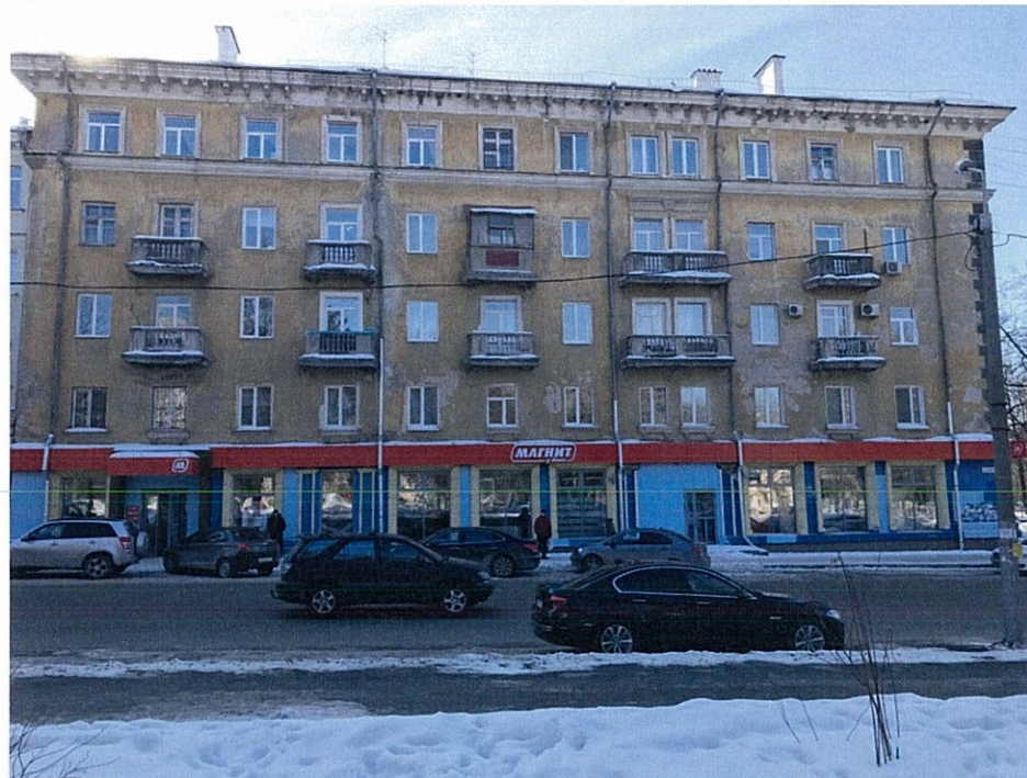
Существующее состояние главного фасада (фотофиксация).
