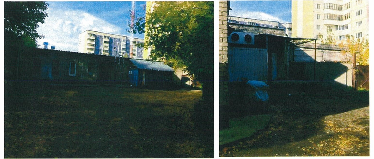
Существующее состояние дворового фасада (фотофиксация).
