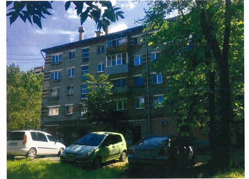
Существующее состояние фасадов (фотофиксация)
