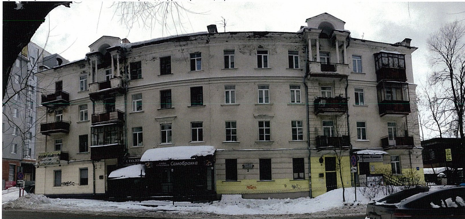
Существующее состояние главного фасада (фотофиксация).
