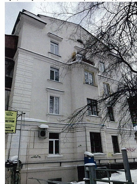
Существующее боковых фасадов (фотофиксация).
