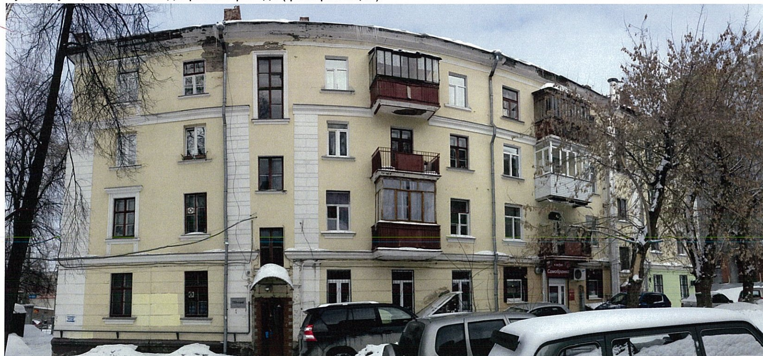
Существующее состояние дворового фасада (фотофиксация).
