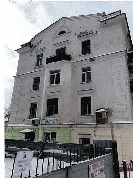
Существующее боковых фасадов (фотофиксация).
