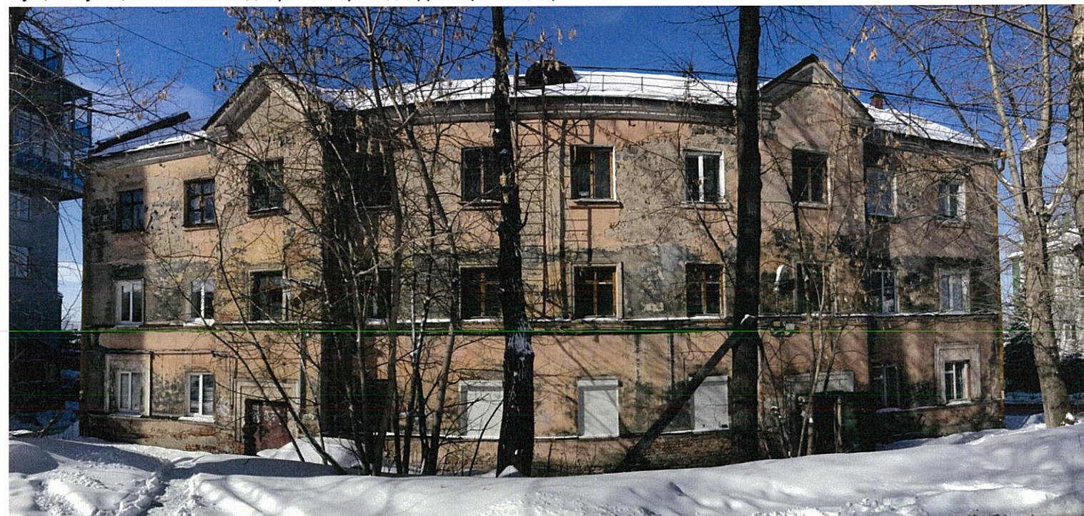
Существующее состояние дворового фасада (фотофиксация).
