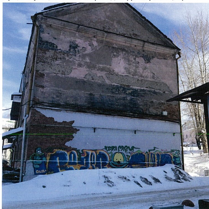
Существующее боковых фасадов (фотофиксация).
