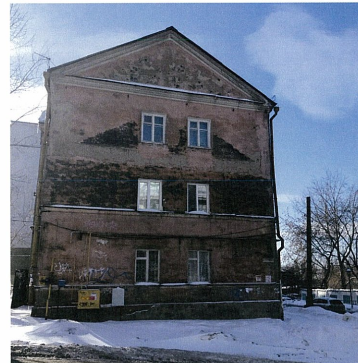
Существующее боковых фасадов (фотофиксация).
