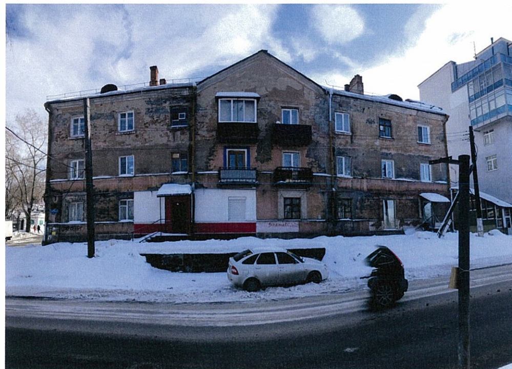
Существующее состояние главного фасада (фотофиксация).
