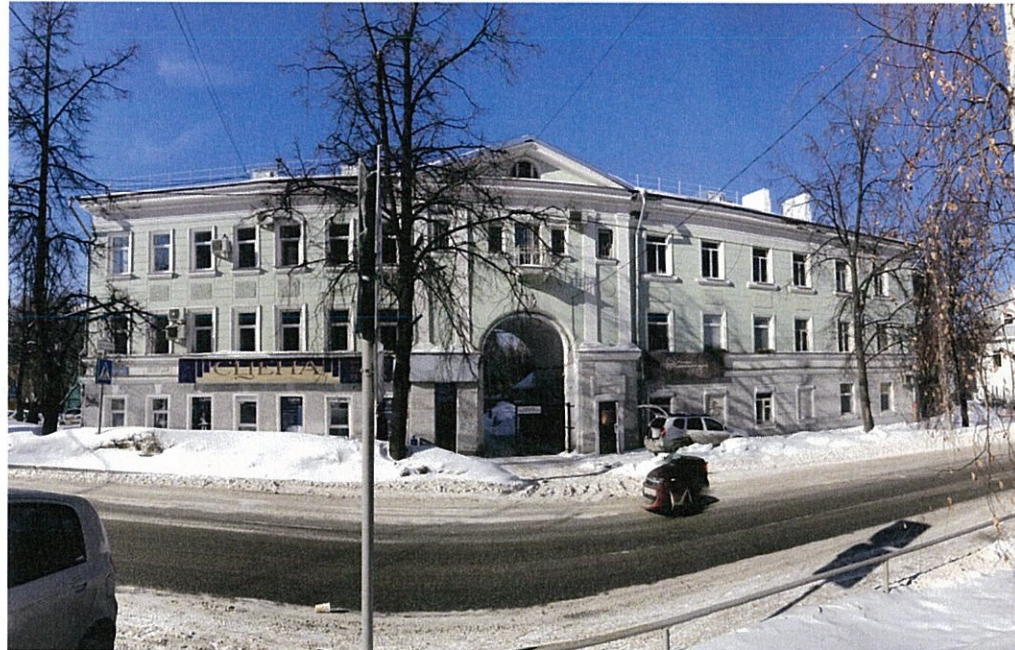
Существующее состояние главного фасада (фотофиксация).
