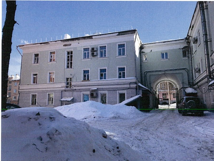
Существующее состояние дворового фасада (фотофиксация).
