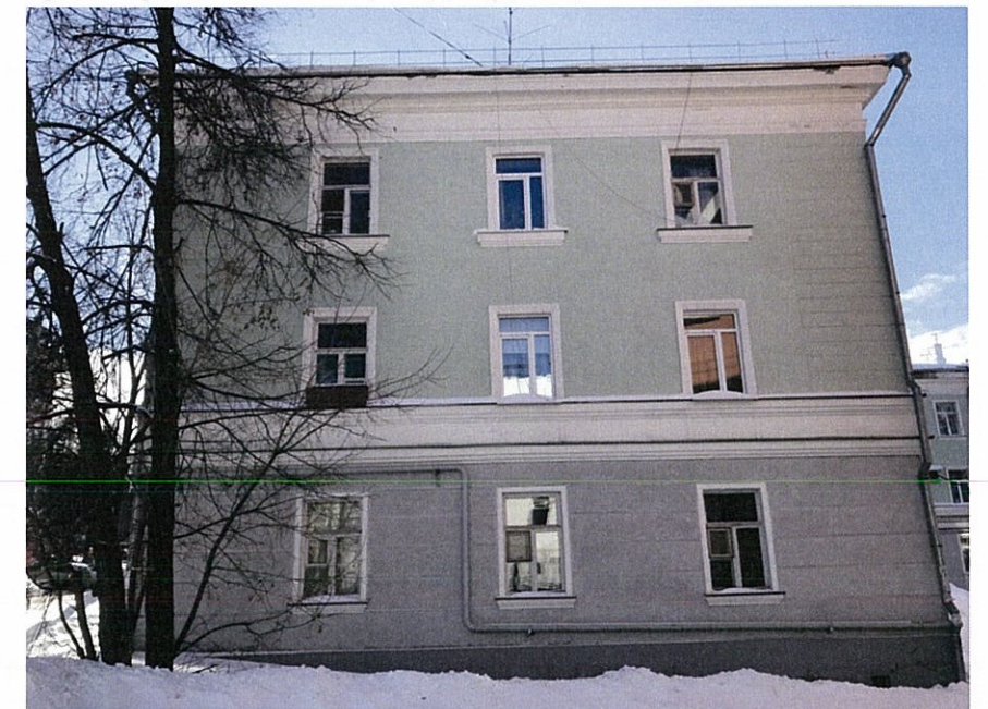
Существующее боковых фасадов (фотофиксация).
