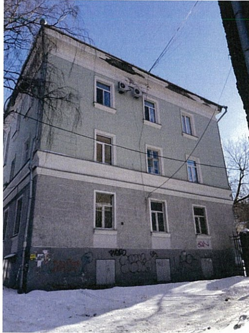
Существующее боковых фасадов (фотофиксация).
