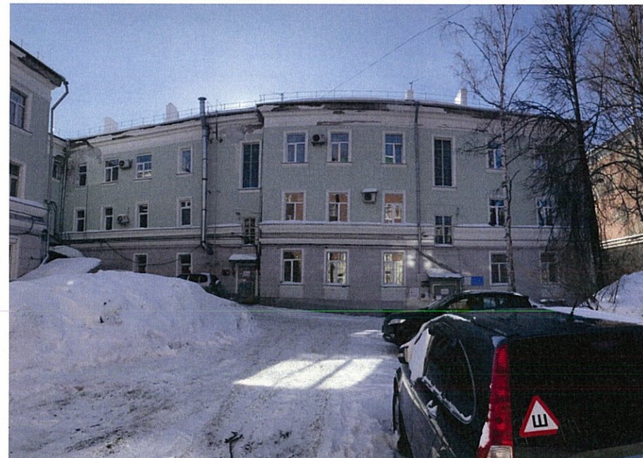
Существующее состояние дворового фасада (фотофиксация).
