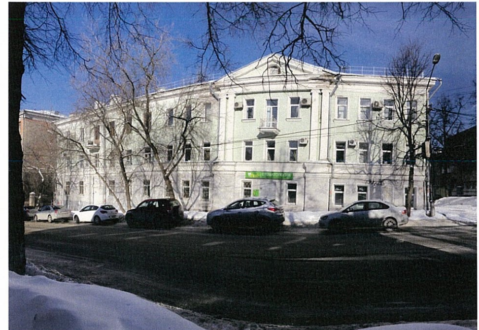
Существующее состояние главного фасада (фотофиксация).
