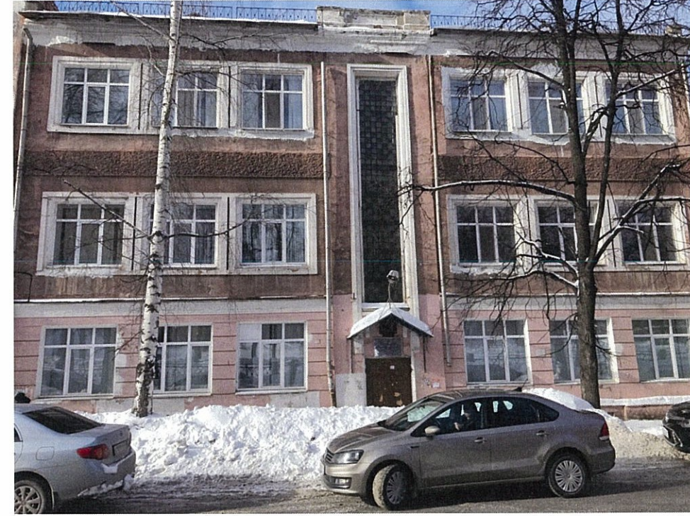
Существующее состояние главного фасада (фотофиксация).
