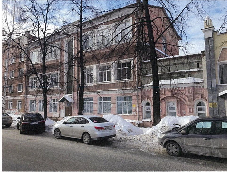
Существующее состояние главного фасада (фотофиксация).
