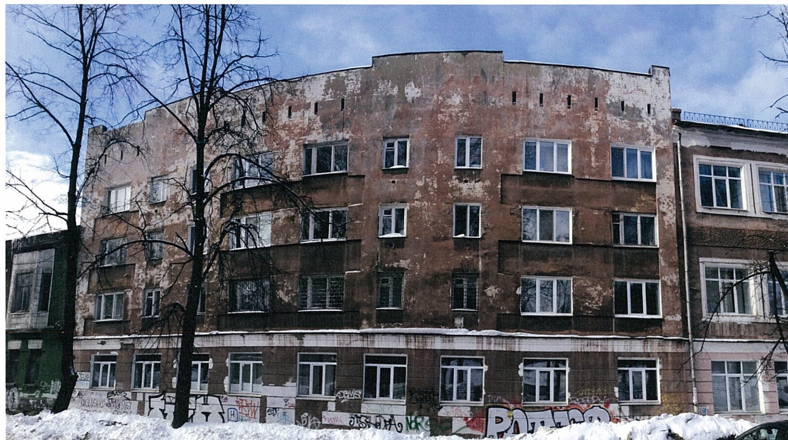
Существующее состояние главного фасада (фотофиксация).
