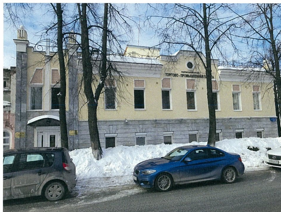
Существующее состояние главного фасада (фотофиксация).
