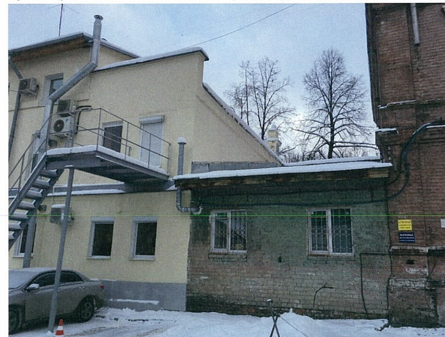
Существующее состояние бокового фасада (фотофиксация).
