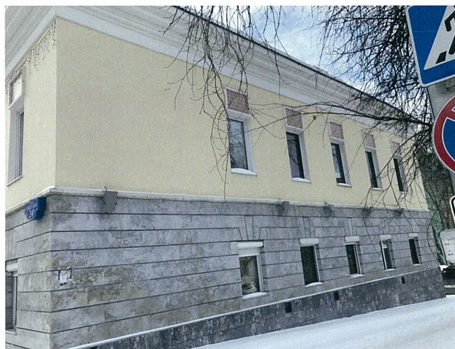
Существующее состояние бокового фасада (фотофиксация).
