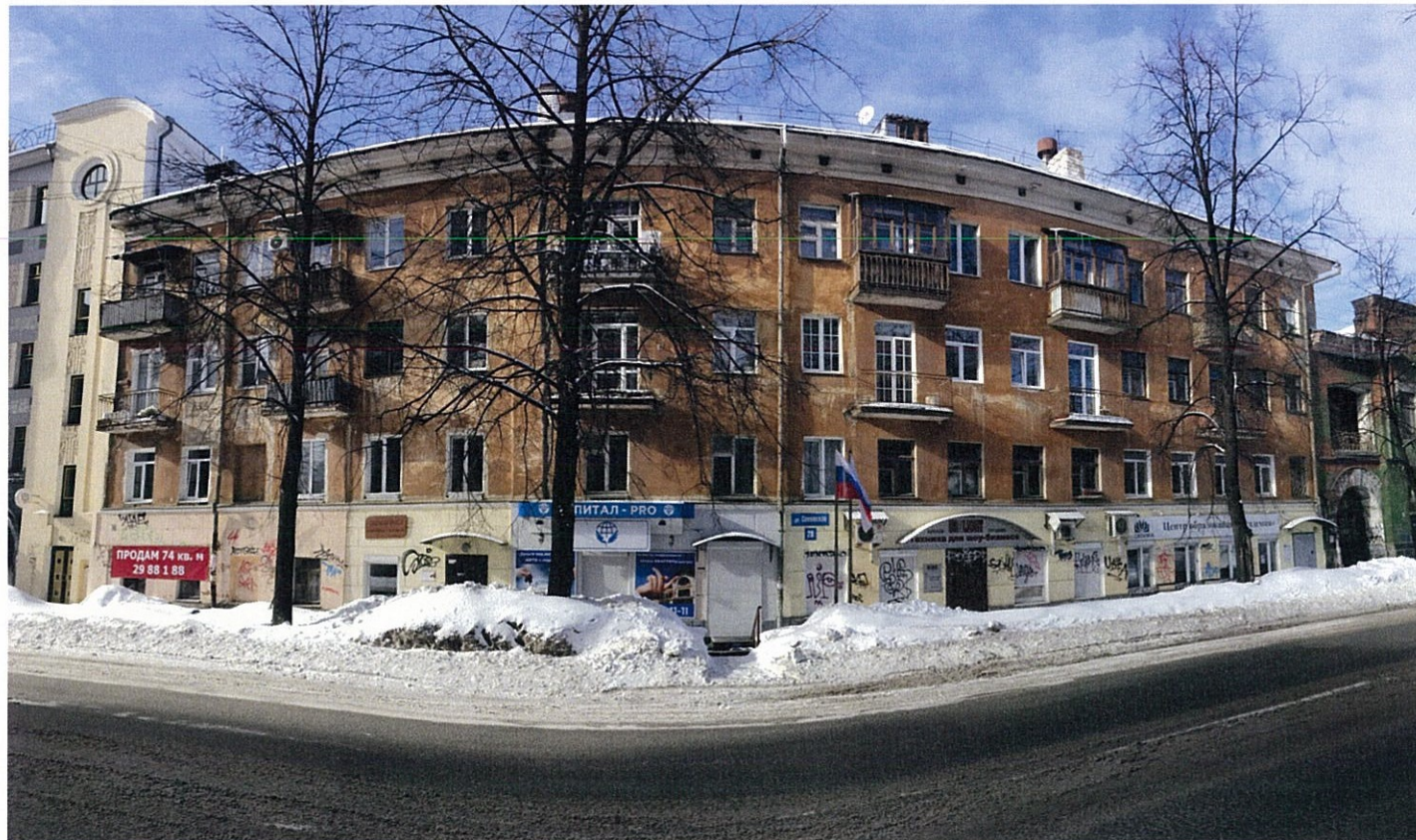
Существующее состояние главного фасада (фотофиксация).
