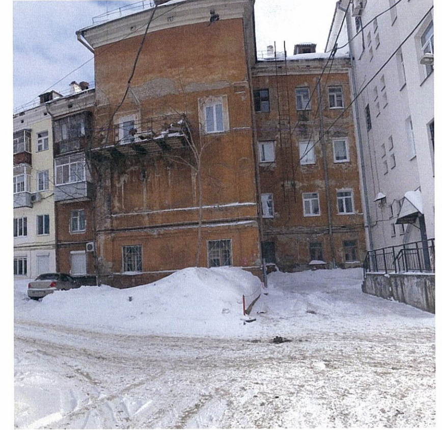
Существующее состояние бокового фасада (фотофиксация).
