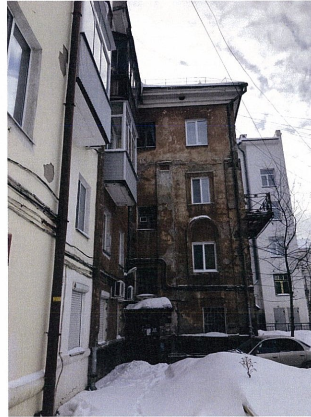
Существующее состояние бокового фасада (фотофиксация).
