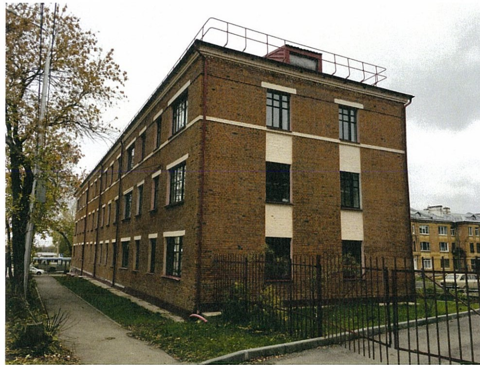
Существующее состояние бокового фасада (фотофиксация).
