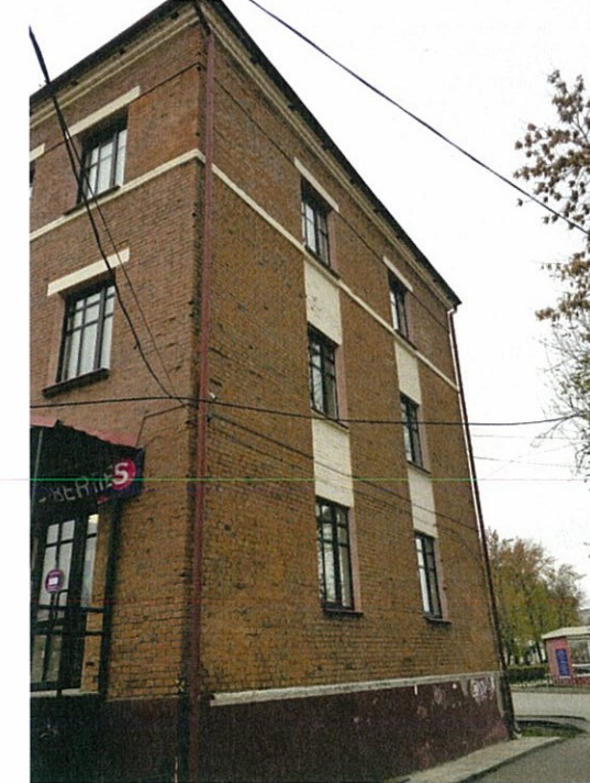
Существующее состояние бокового фасада (фотофиксация).
