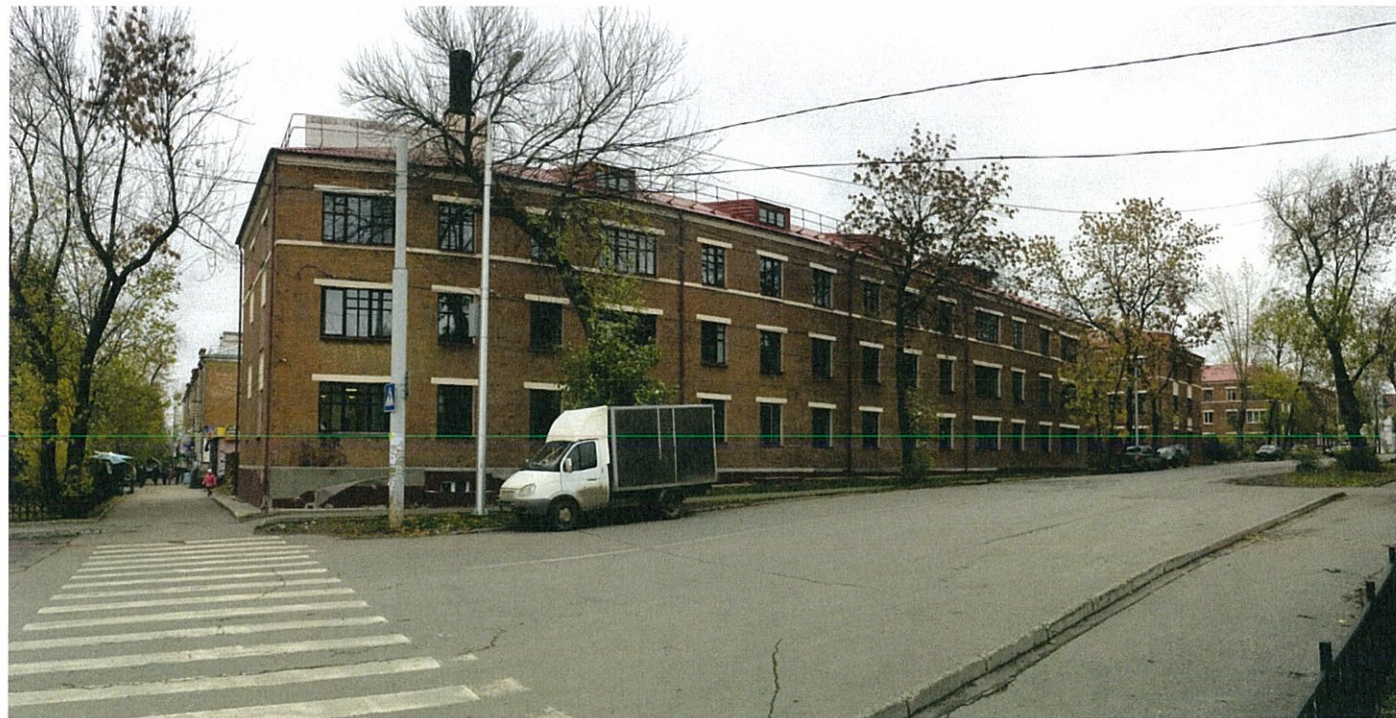
Существующее состояние главного фасада (фотофиксация).
