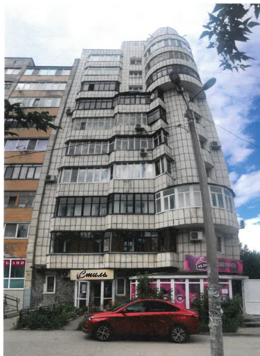
Существующее состояние главного фасада (фотофиксация).
