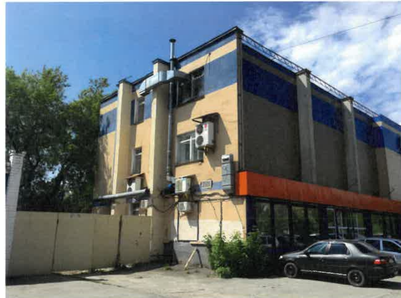
Существующее состояние бокового фасада (фотофиксация).
