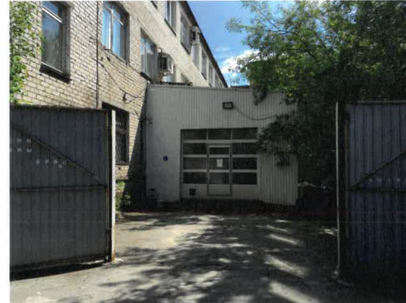
Существующее состояние дворового фасада (фотофиксация).
