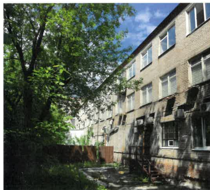
Существующее состояние дворового фасада (фотофиксация).
