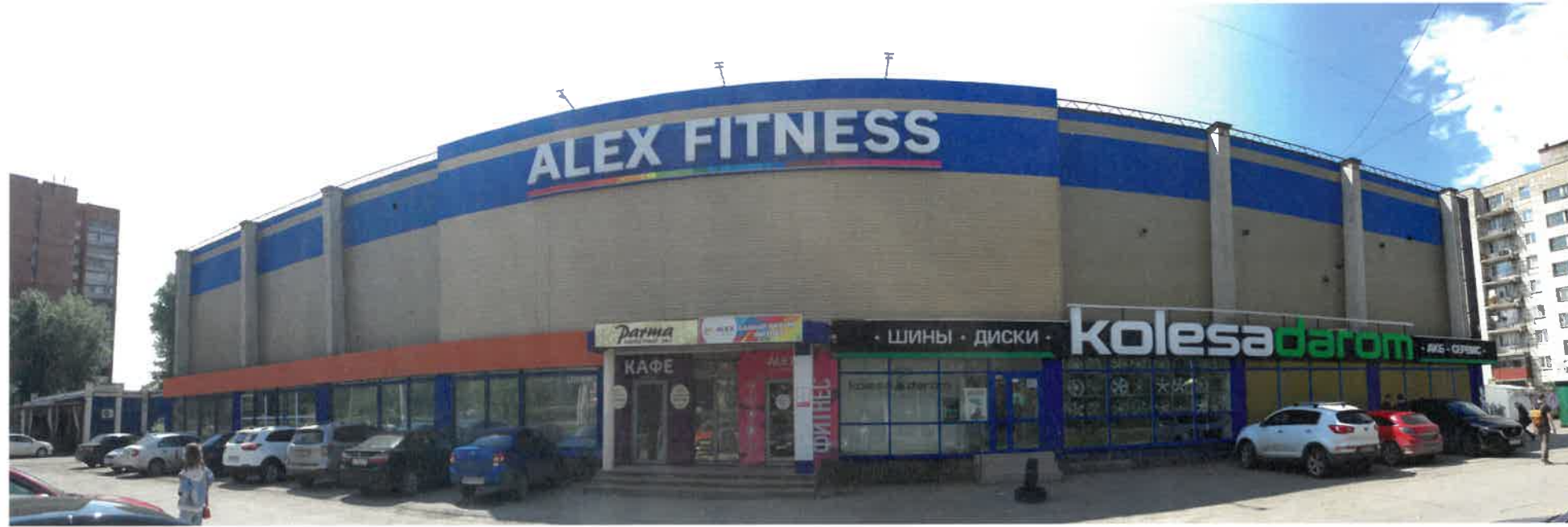
Существующее состояние главного фасада (фотофиксация).
