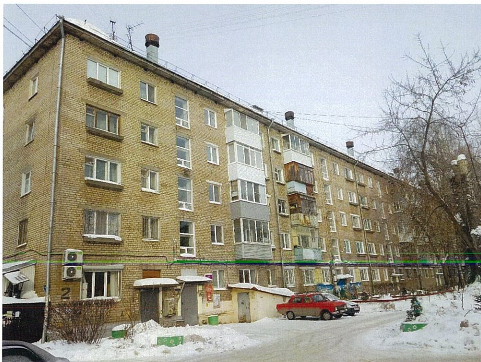
Существующее состояние дворового фасада
