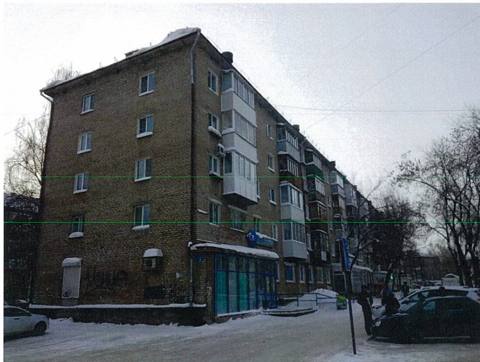
Существующее состояние главного фасада
