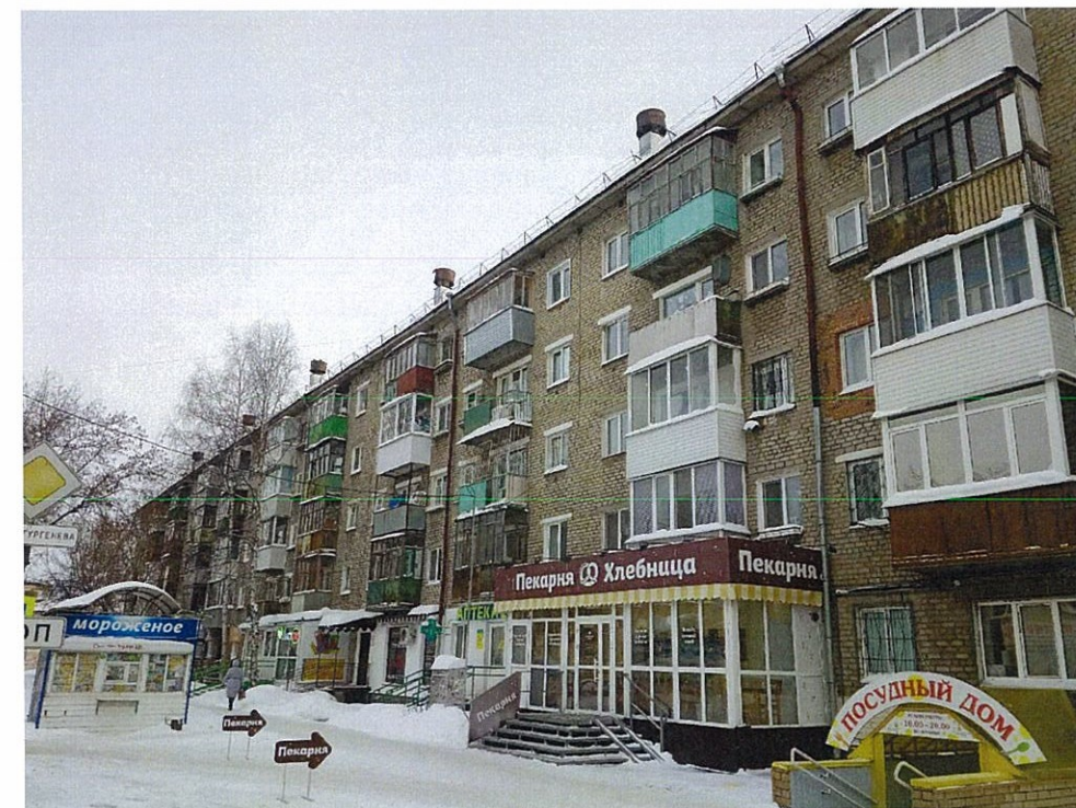
Существующее состояние главного фасада
