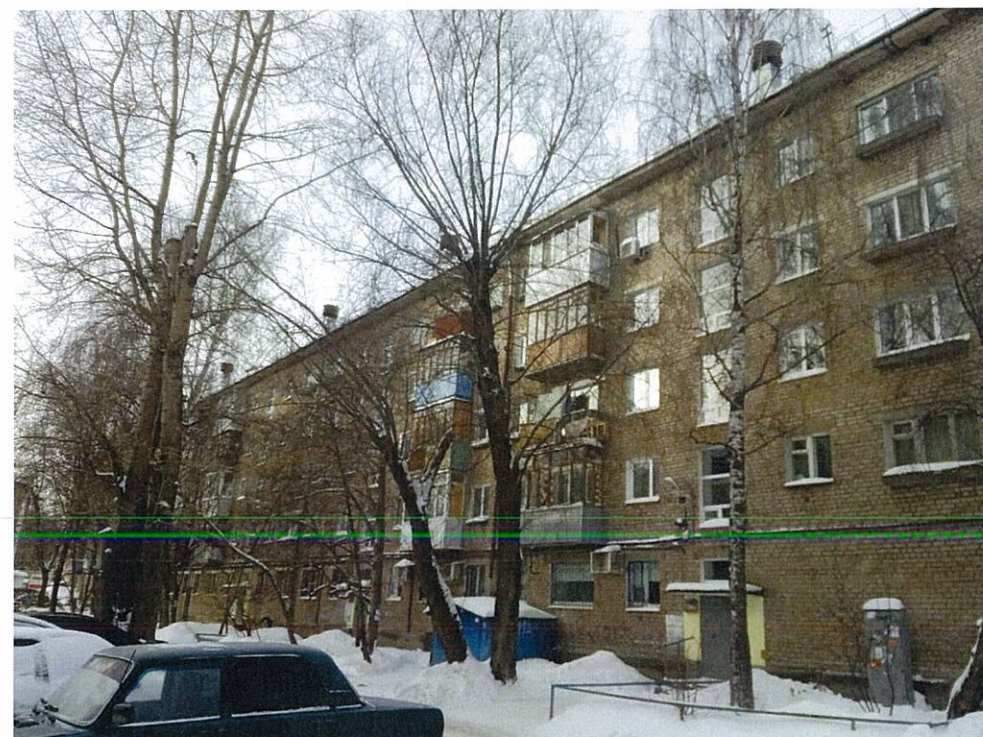
Существующее состояние дворового фасада
