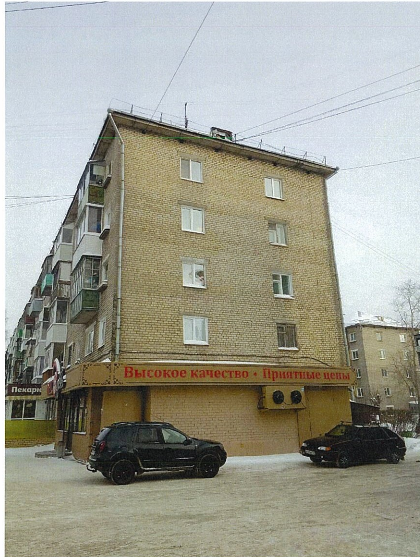
Существующее состояние бокового фасада
