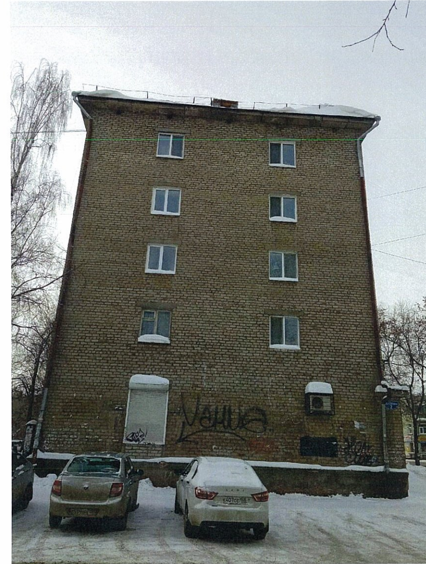
Существующее состояние бокового фасада
