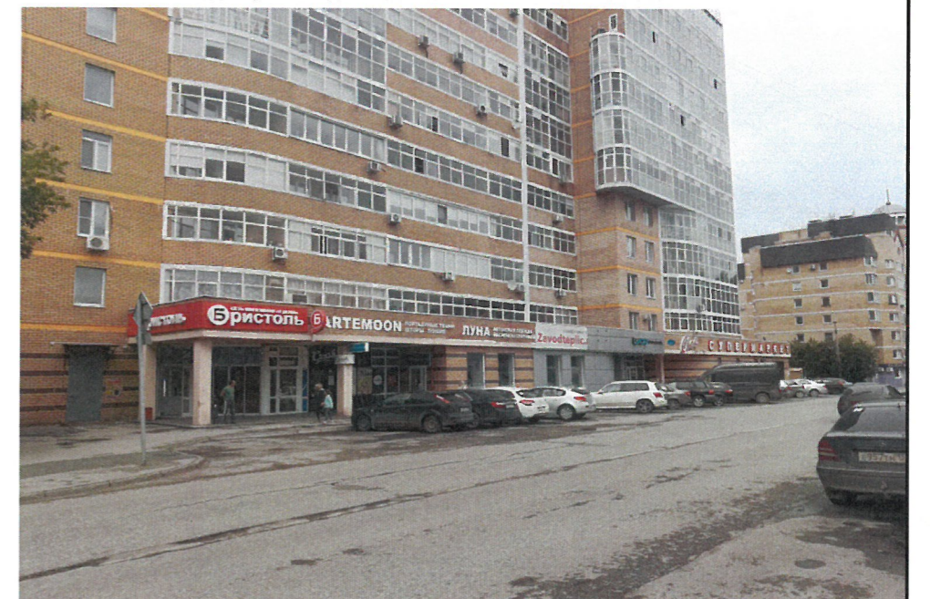
Фрагмент фасада 1-3 по ул. Лебедева
