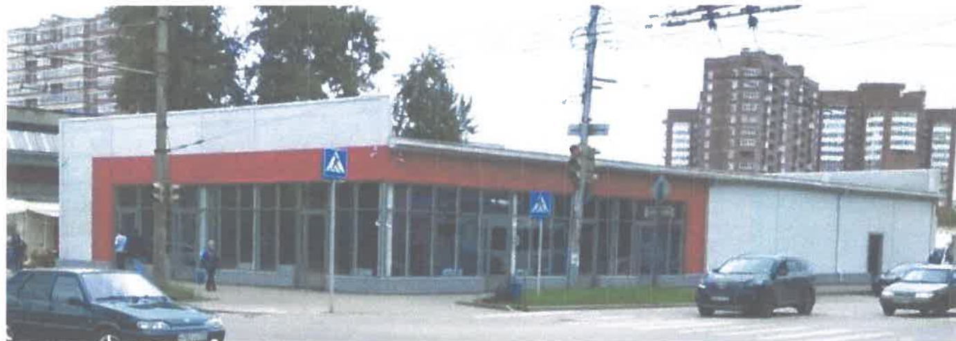
Главный и боковой фасады
