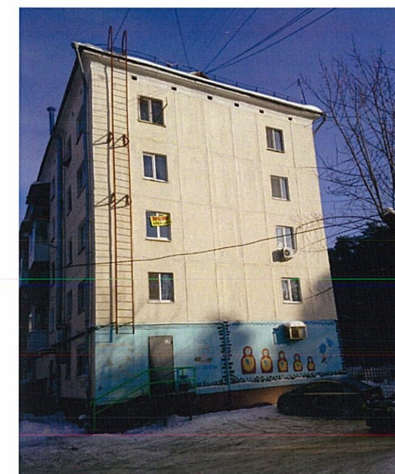
Фотофиксация существующего фасада по осям 2-А-Б
