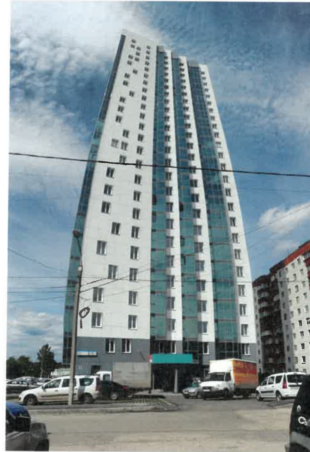
Существующее состояние бокового фасада (фотофиксация).
