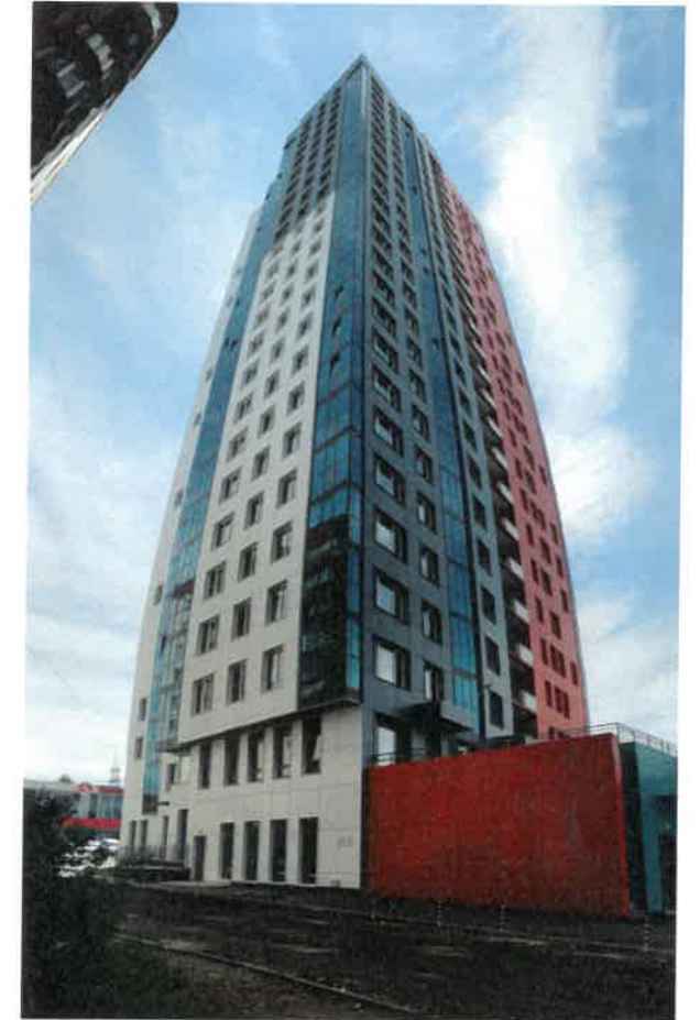
Существующее состояние бокового фасада (фотофиксация).
