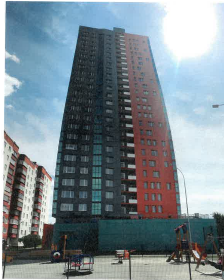
Существующее состояние дворового фасада (фотофиксация).
