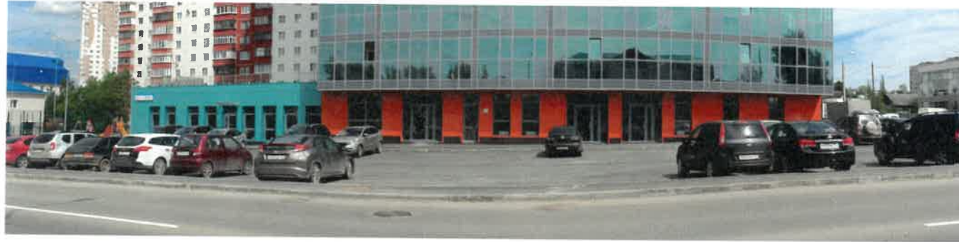
Существующее состояние главного фасада (фотофиксация).
