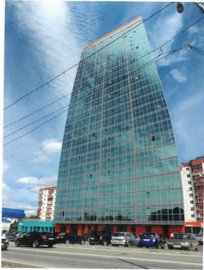
Существующее состояние главного фасада (фотофиксация).
