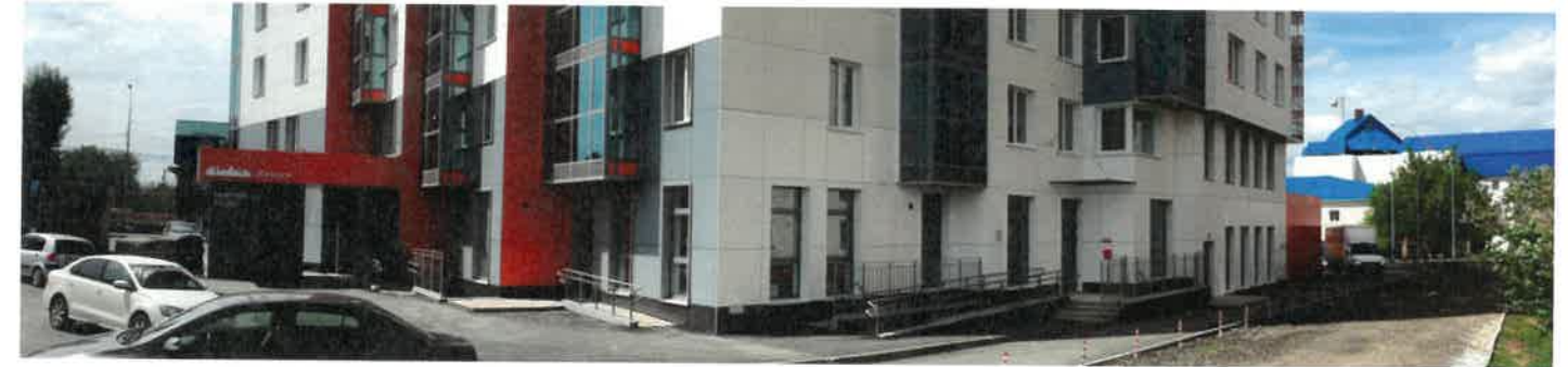
Существующее состояние бокового фасада (фотофиксация).
