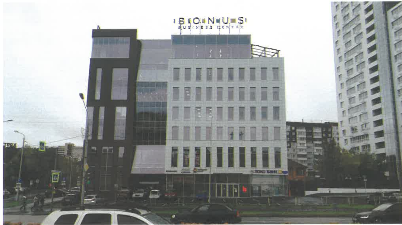
Существующий фасад в осях 3-1
