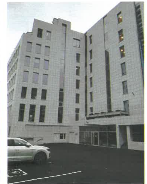
Существующий фасад в осях Г-Д
