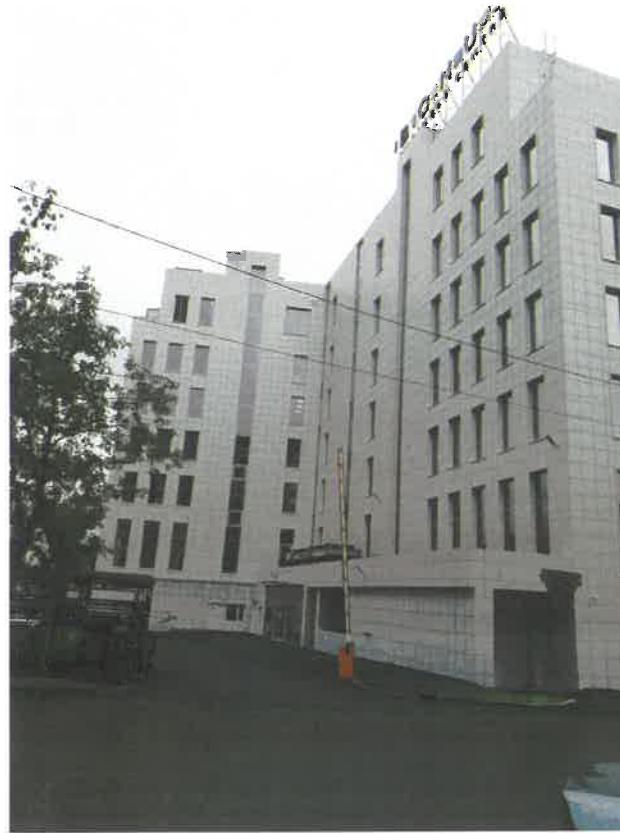
Существующий фасад в осях 1-2
