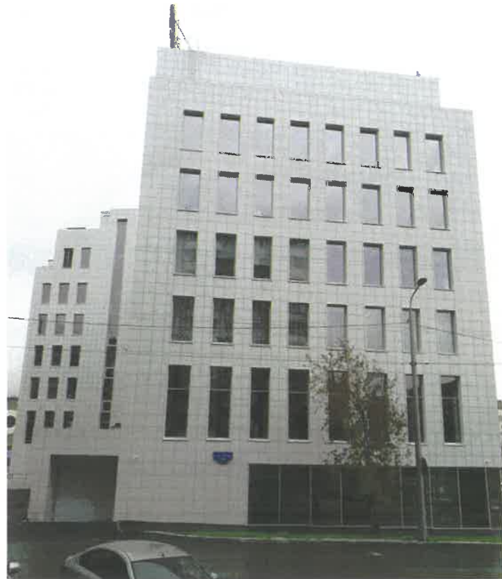
Существующий фасад в осях 3-2
