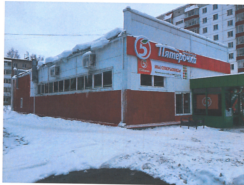
Главный фасад Б-А и боковой фасад 6-1
