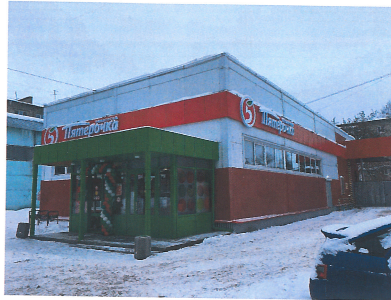
Главный фасад Б-А и боковой фасад 1-6
