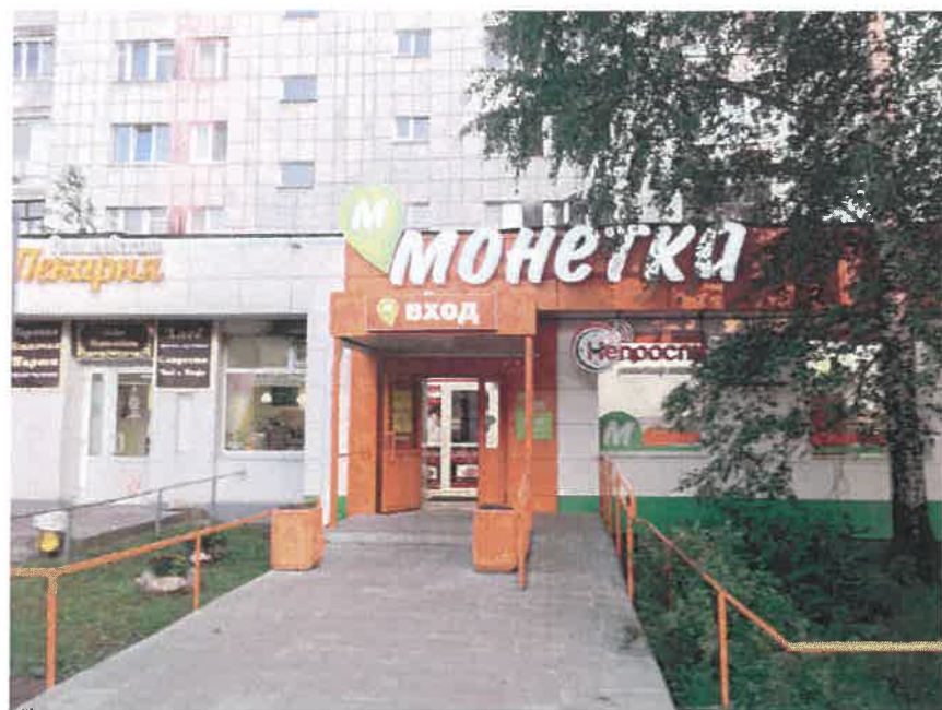
Существующее состояние главного фасада (фотофиксация)
