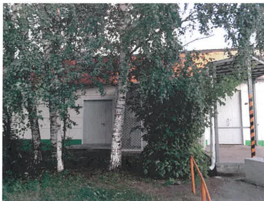
Существующее состояние главного фасада (фотофиксация)
