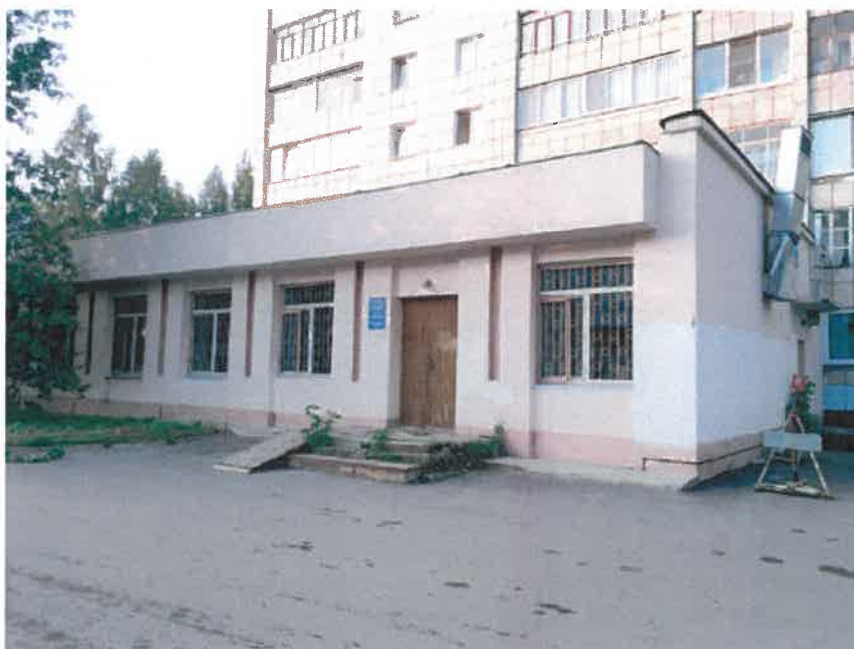
Существующее состояние главного фасада (фотофиксация)
