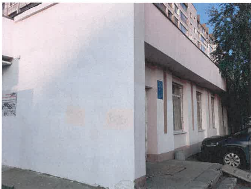
Существующее состояние главного фасада (фотофиксация)
