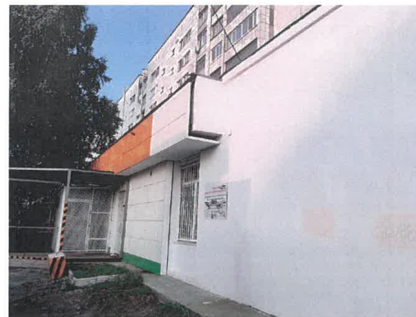
Существующее состояние главного фасада (фотофиксация)
