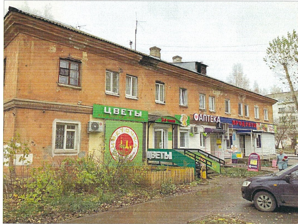
Существующее состояние главного фасада по ул. Академика Веденеева (фотофиксация).
