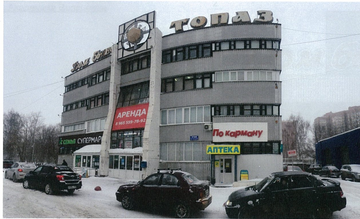
Существующее состояние главного фасада (фотофиксация).
