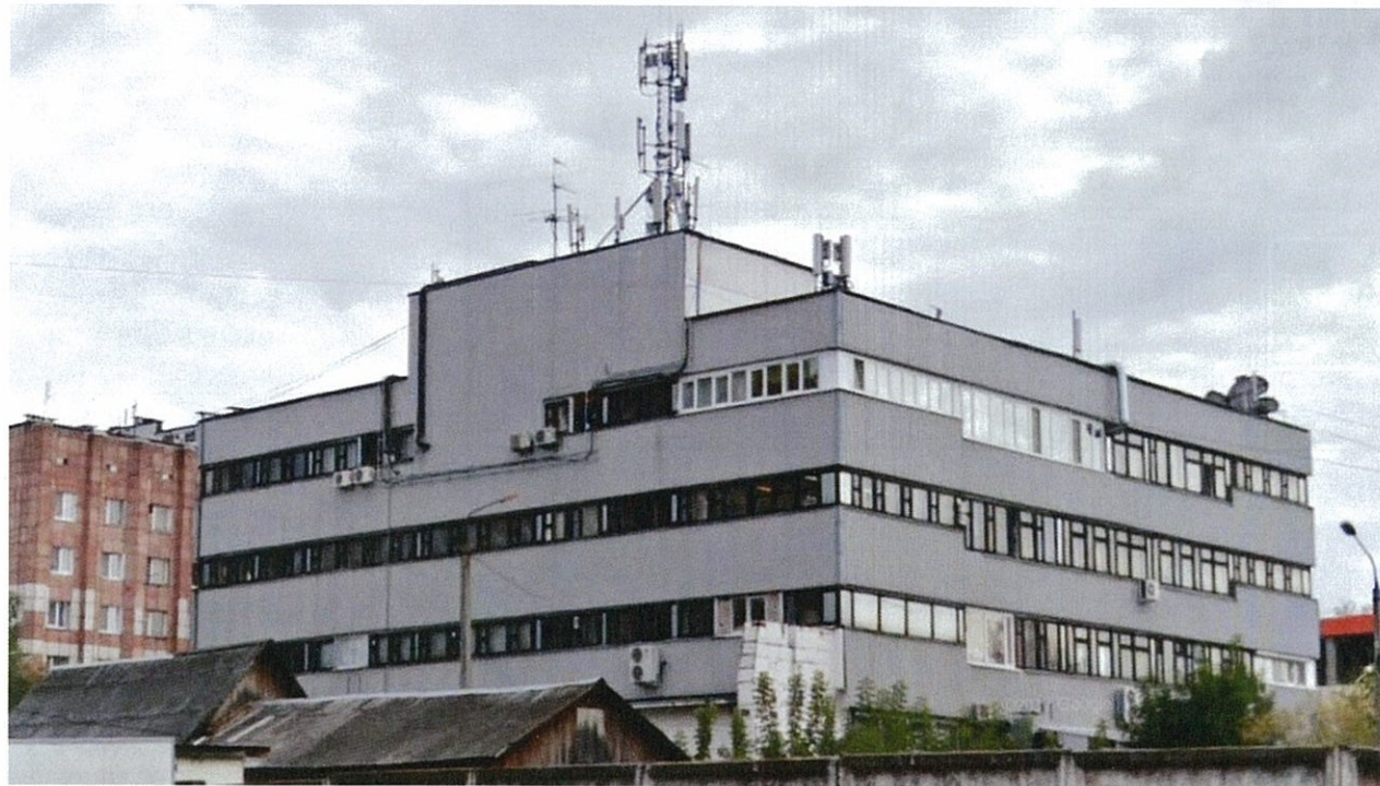
Существующее состояние дворового фасада (фотофиксация).
