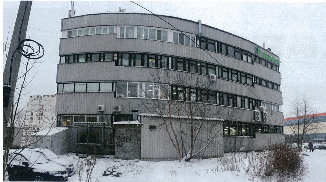
Существующее состояние бокового фасада (фотофиксация).
