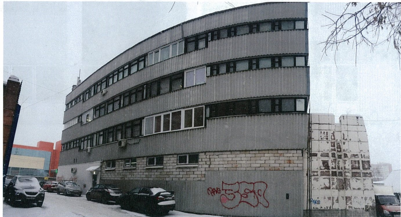
Существующее состояние бокового фасада (фотофиксация).
