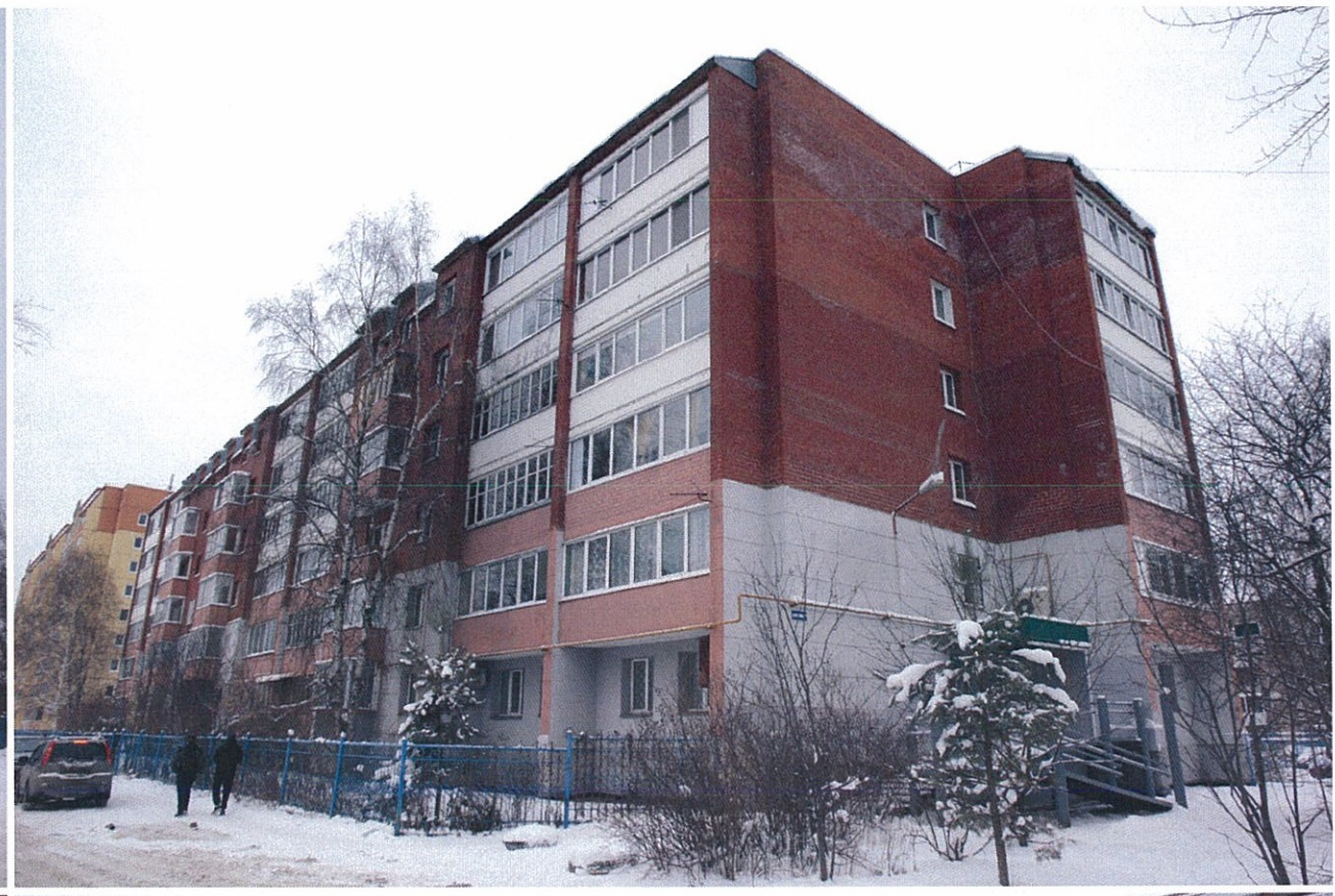
Главный фасад в осях 1-4 и боковой фасад в осях А-В
