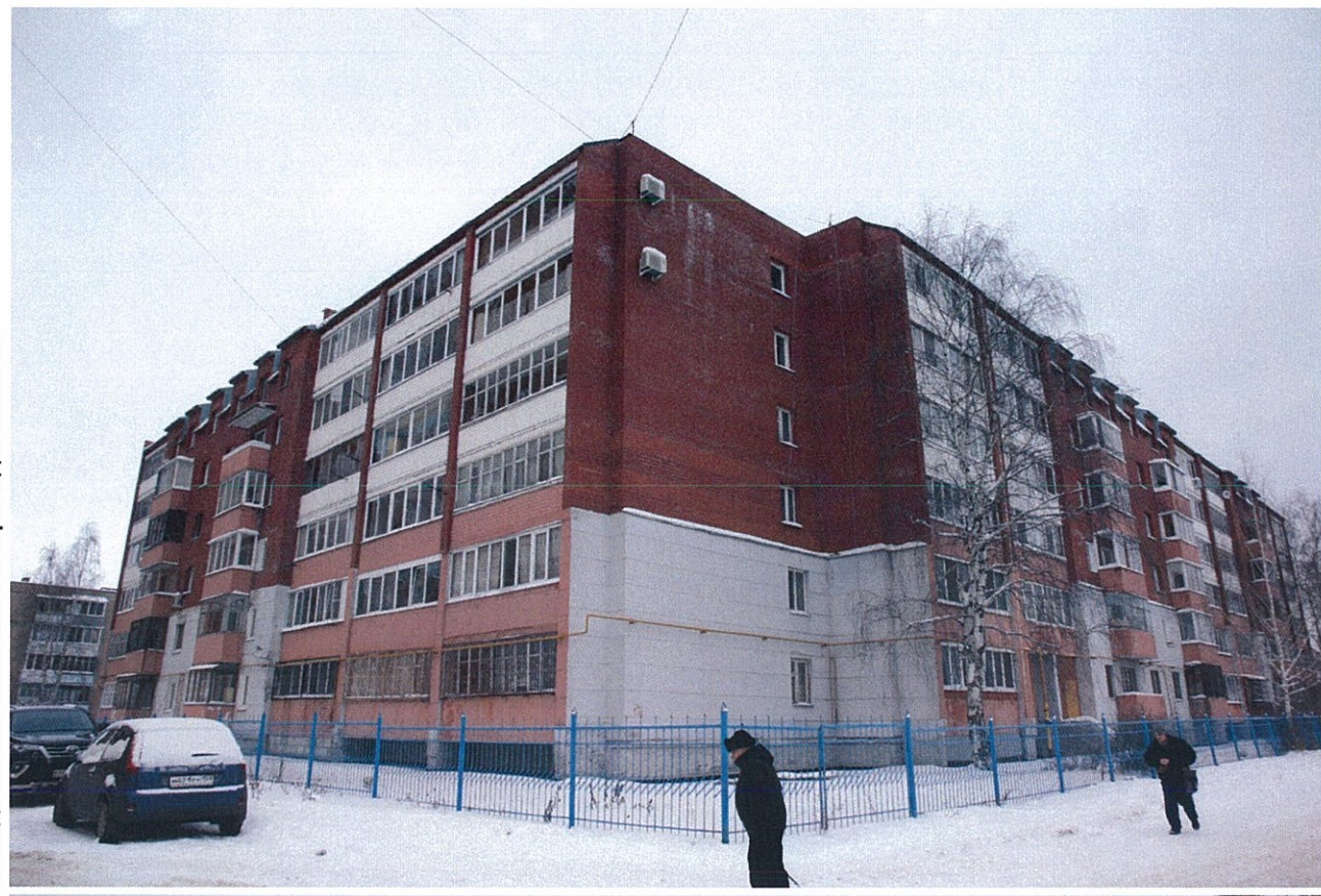
Фасад в осях Г-В и главный фасад в осях 1-4
