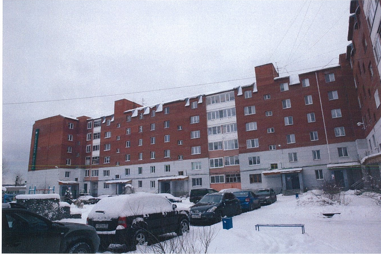
Дворовой фасад в осях 4-2
