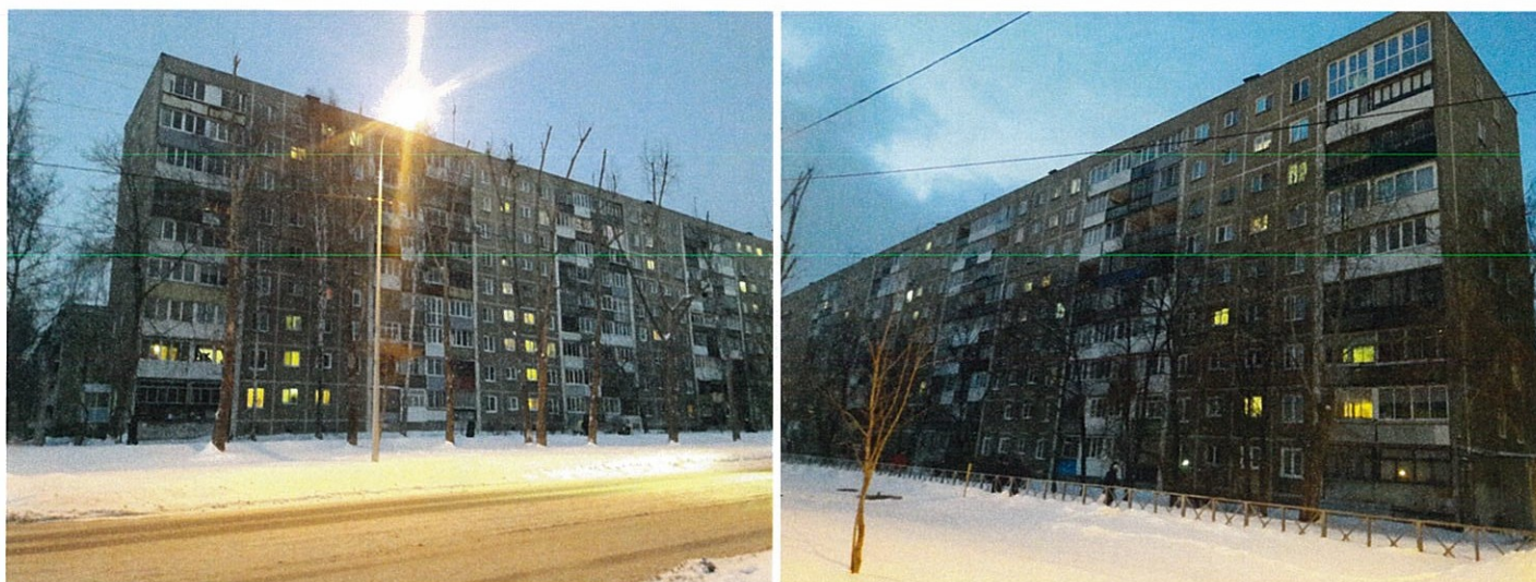
Существующее состояние главного фасада (фотофиксация).
