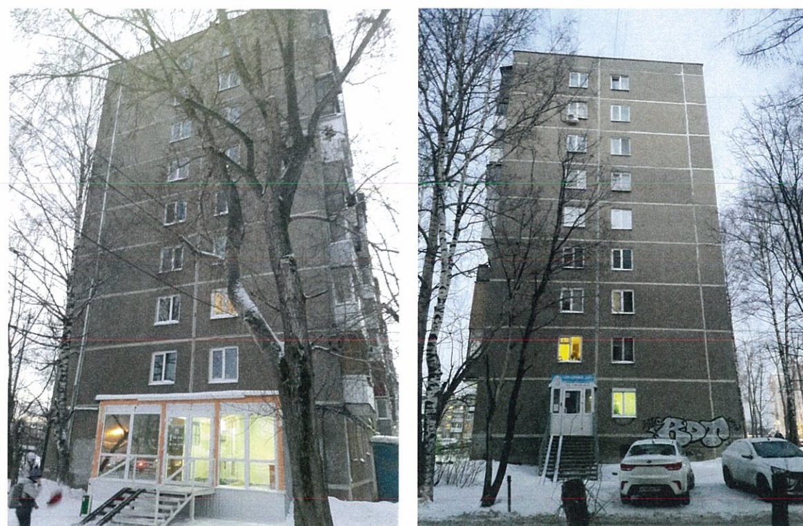
Существующее состояние бокового фасада (фотофиксация).
