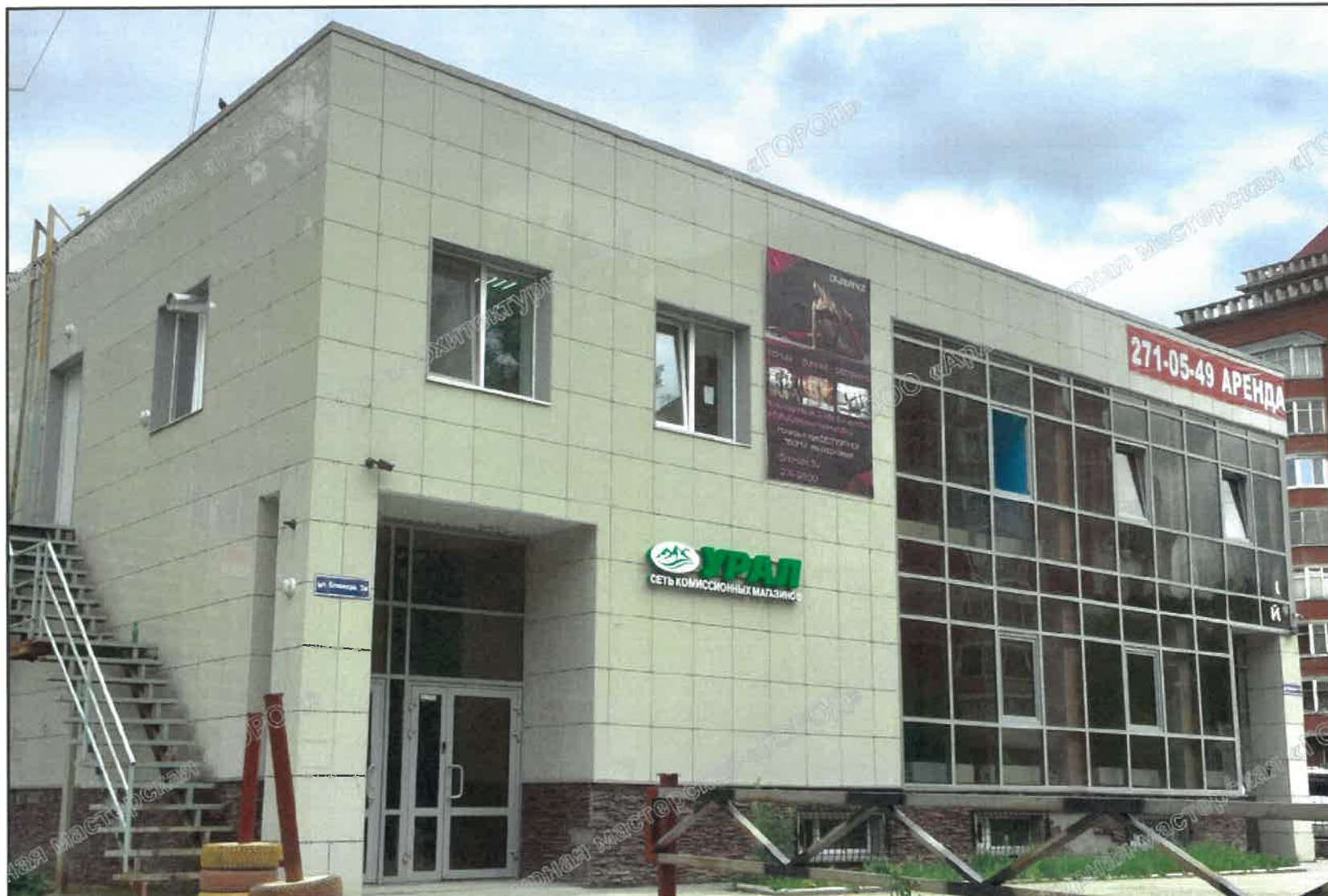
Виды на главный и боковые фасады
