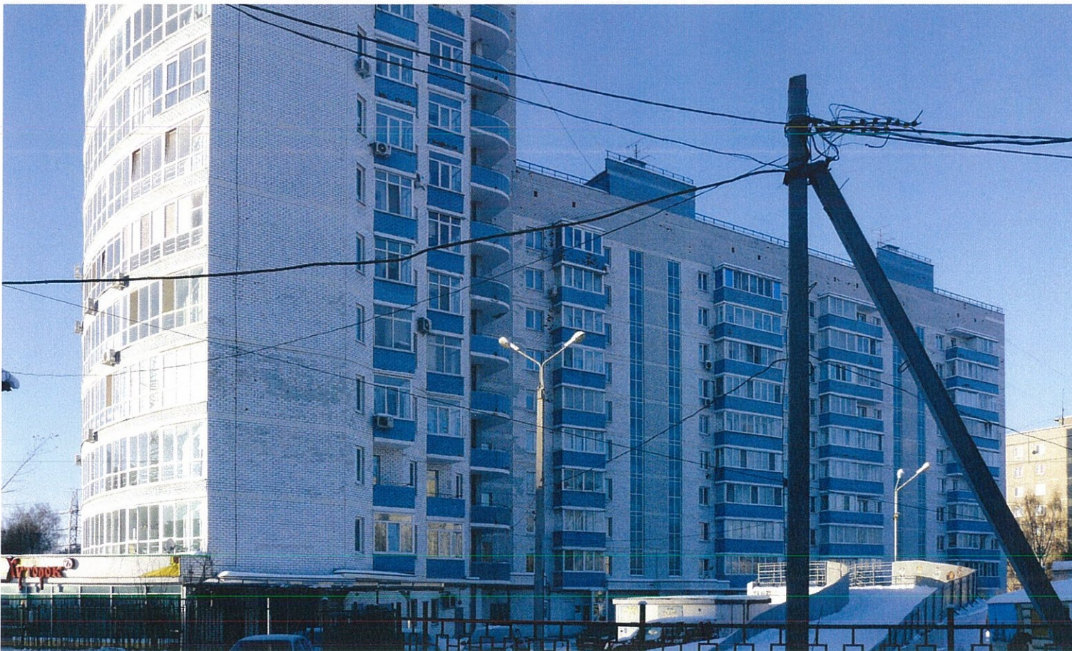
Вид на дворовой фасад 2-1
