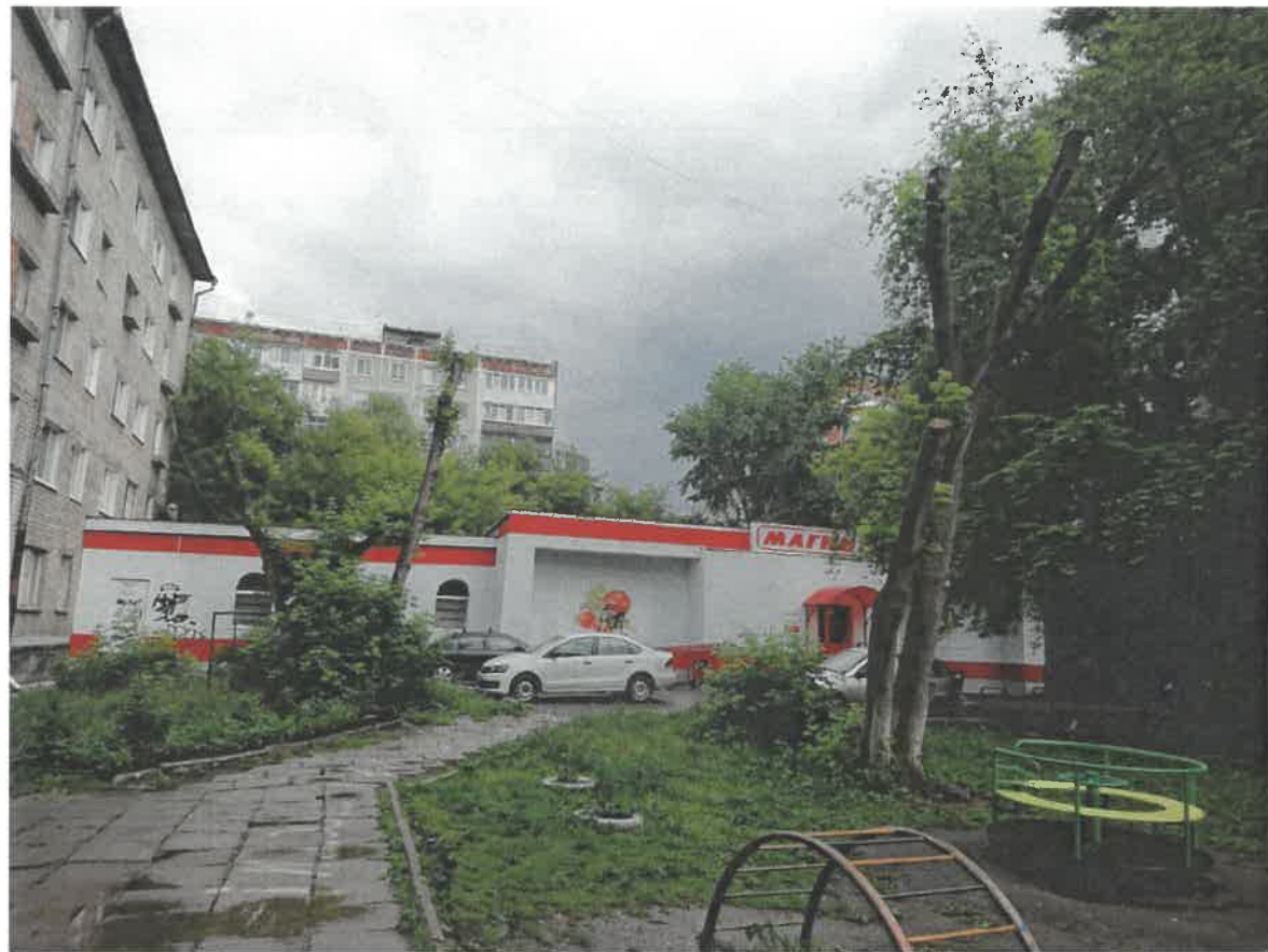
Существующее состояние главного фасада
