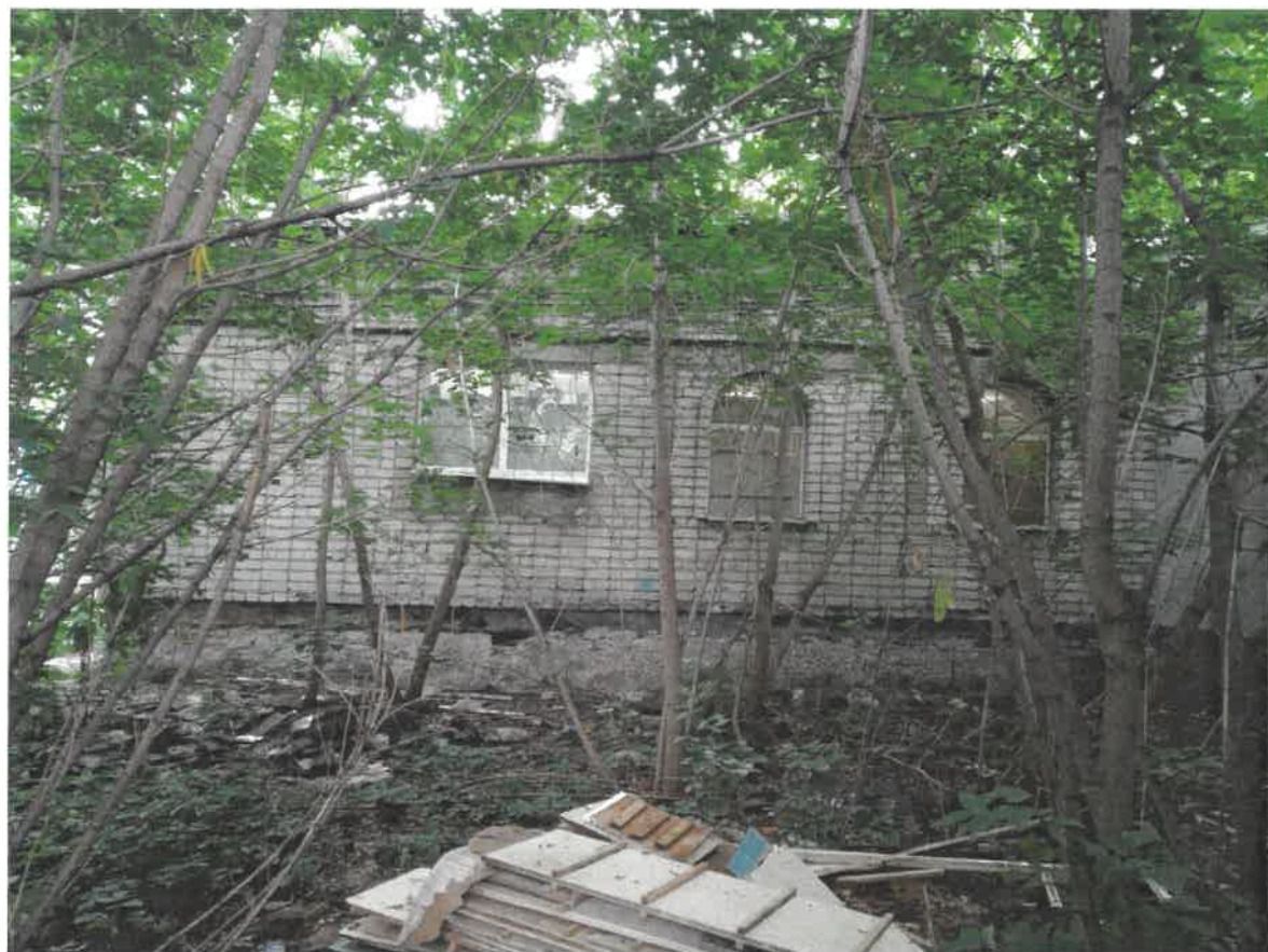
Существующее состояние бокового фасада
