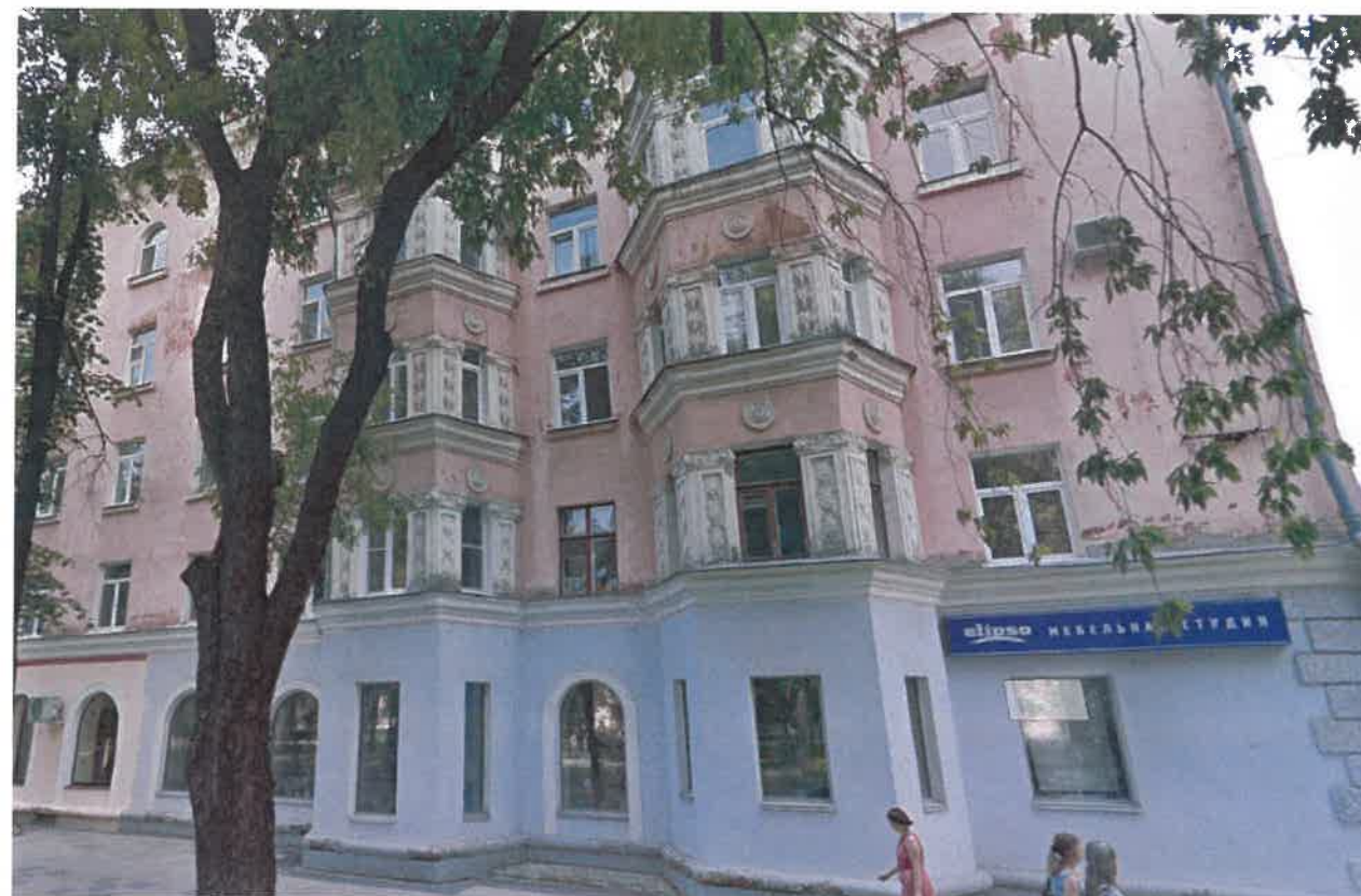
Существующее бокового фасада
