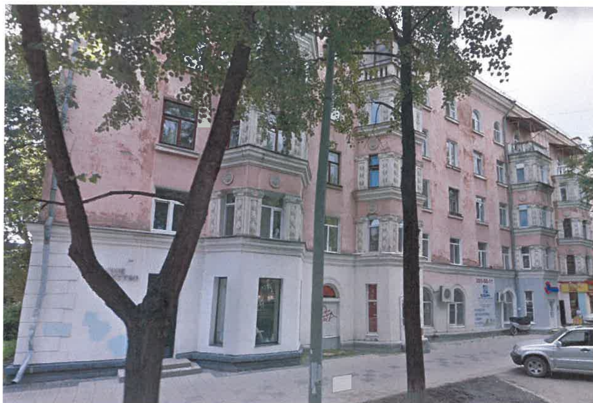
Существующее состояние главного фасада
