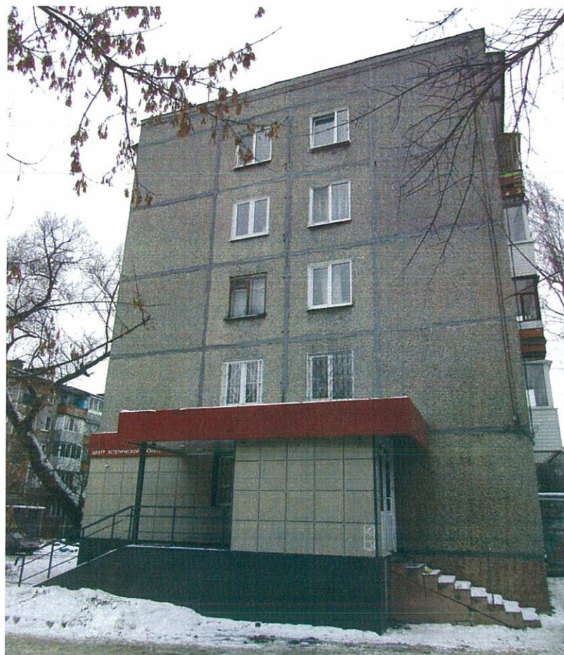
Существующее состояние бокового фасада
