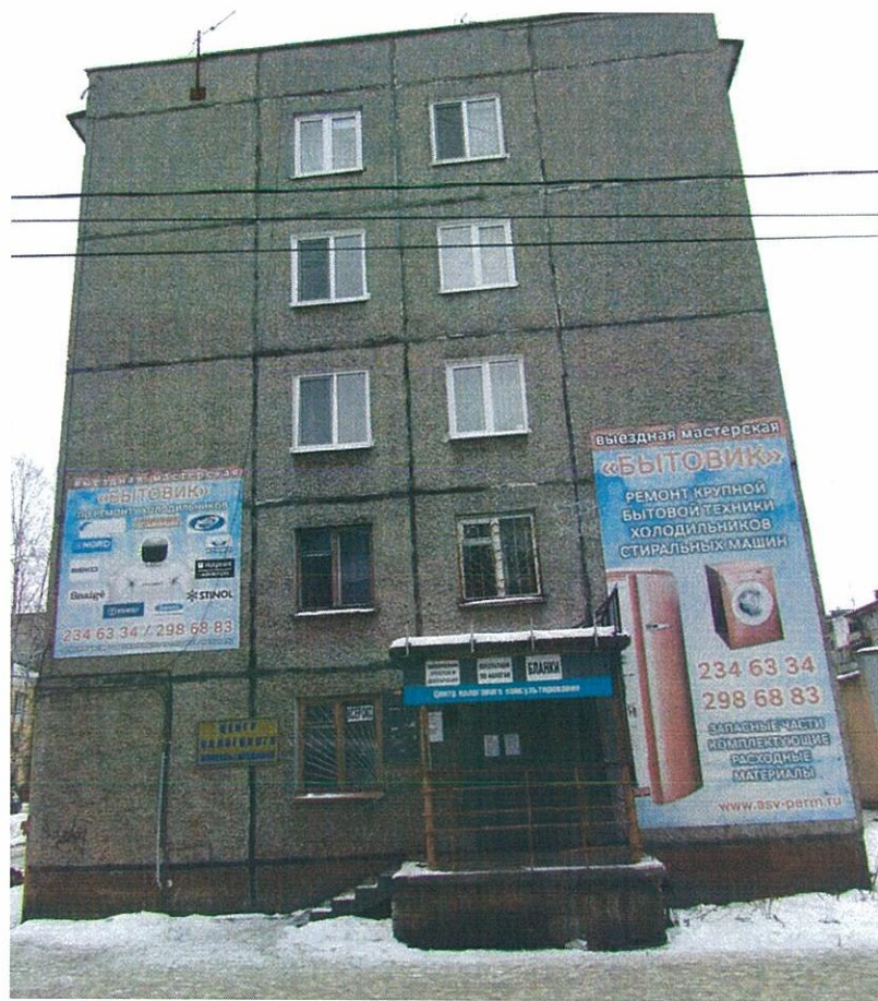
Существующее состояние главного фасада
