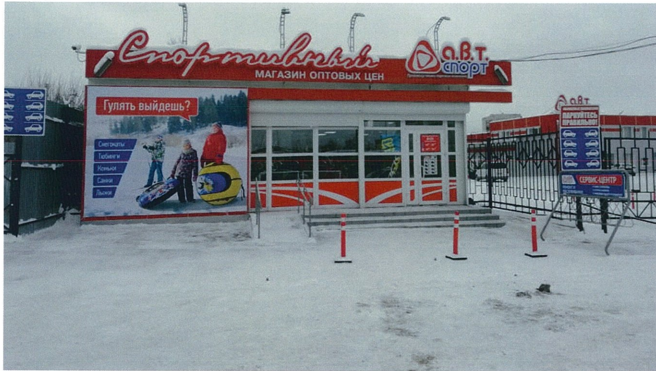
Существующее состояние главного фасада (фотофиксация).
