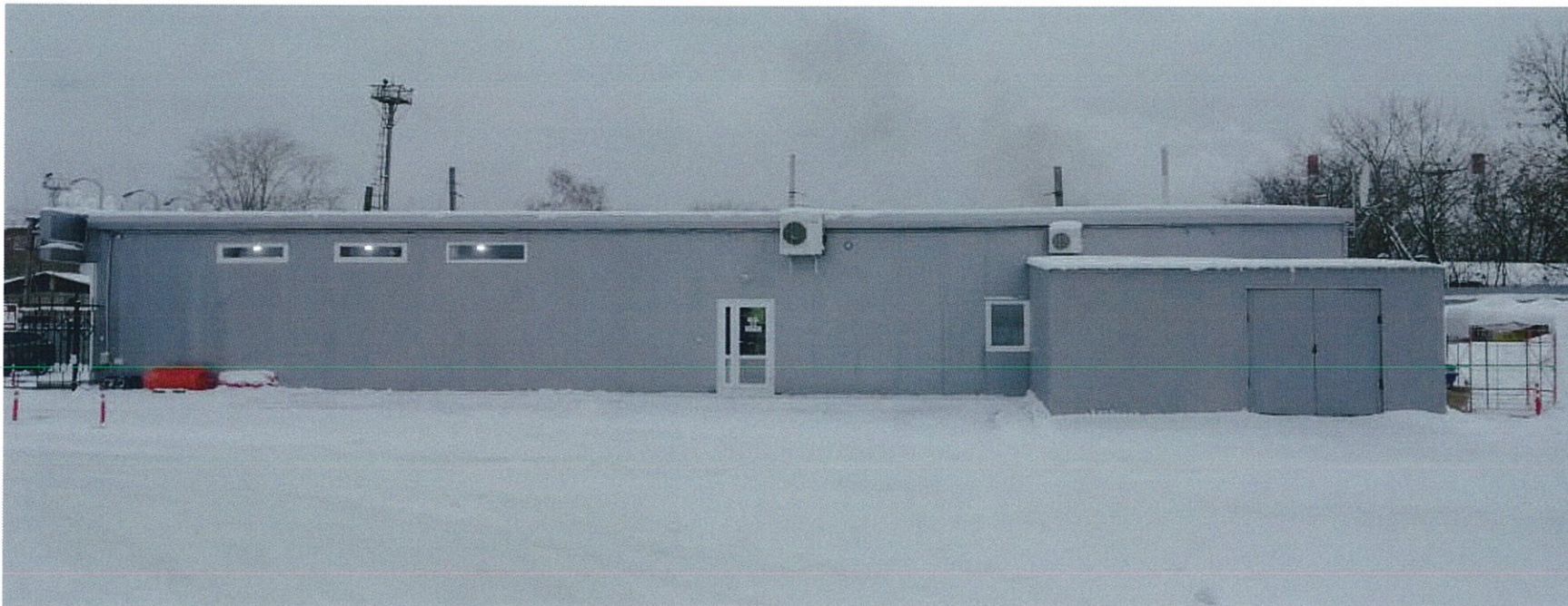
Существующее состояние бокового фасада (фотофиксация).
