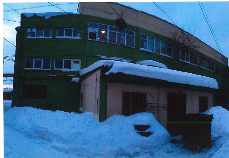
Существующее состояние бокового фасада, ВИД Б
