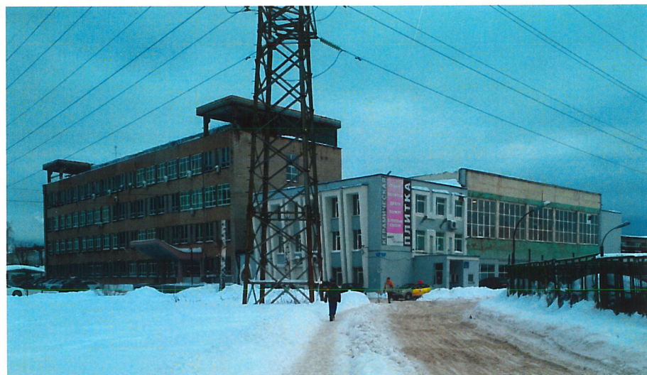
Существующее состояние главного фасада, ВИД А
