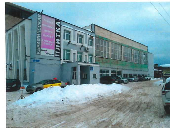
Существующее состояние бокового фасада, ВИД Г
