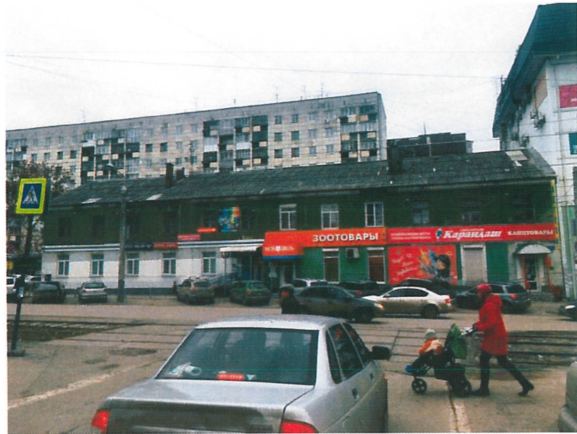
Существующее состояние главного фасада (фотофиксация).
