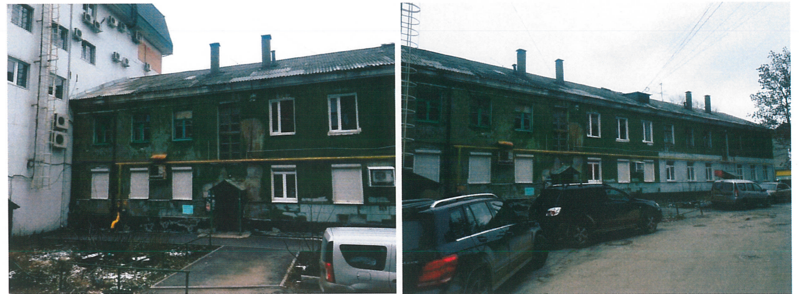
Существующее состояние дворового фасада (фотофиксация).
