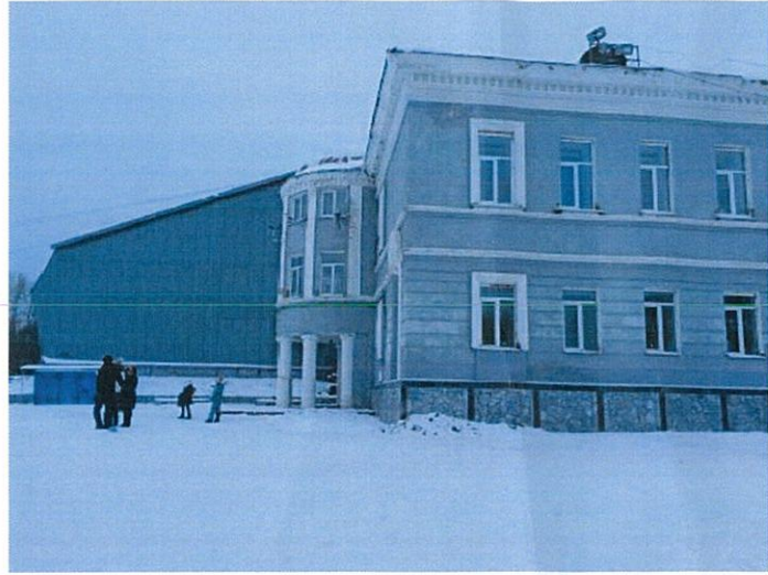
Существующее состояние бокового фасада (фотофиксация)
