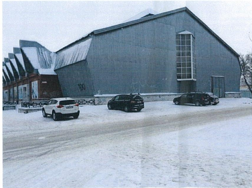
Существующее состояние бокового фасада (фотофиксация)
