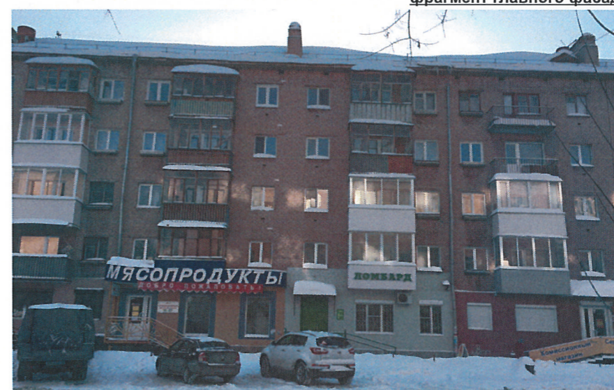
фрагмент главного фасада
