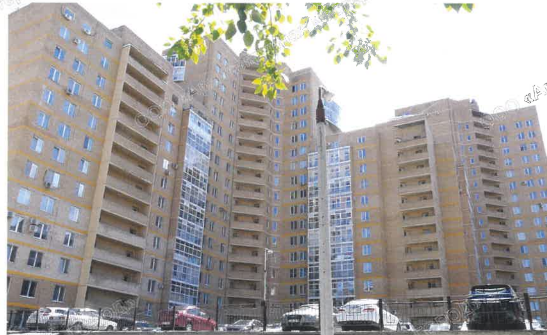
Вид на дворовые фасады
