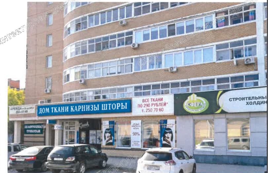
Фрагмент фасада 1-3 по ул. Лебедева
