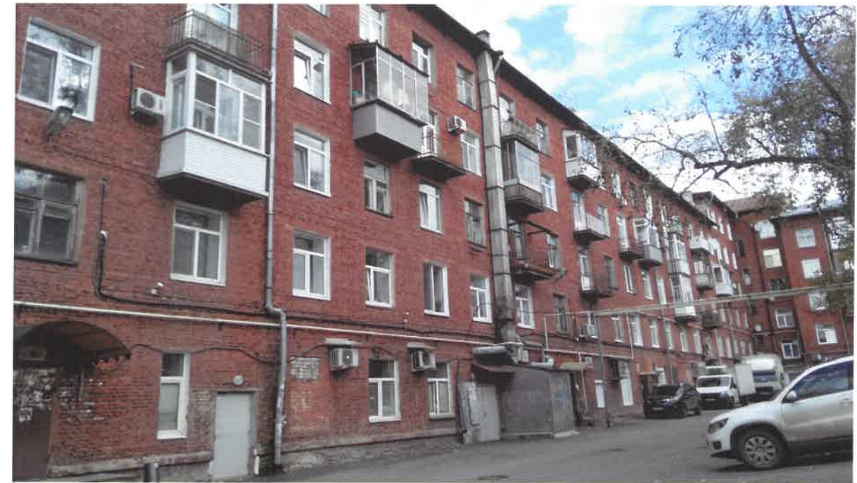
Существующее состояние дворового фасада (фотофиксация)
