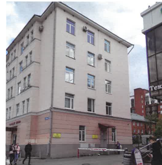
Существующее состояние бокового фасада (фотофиксация)
