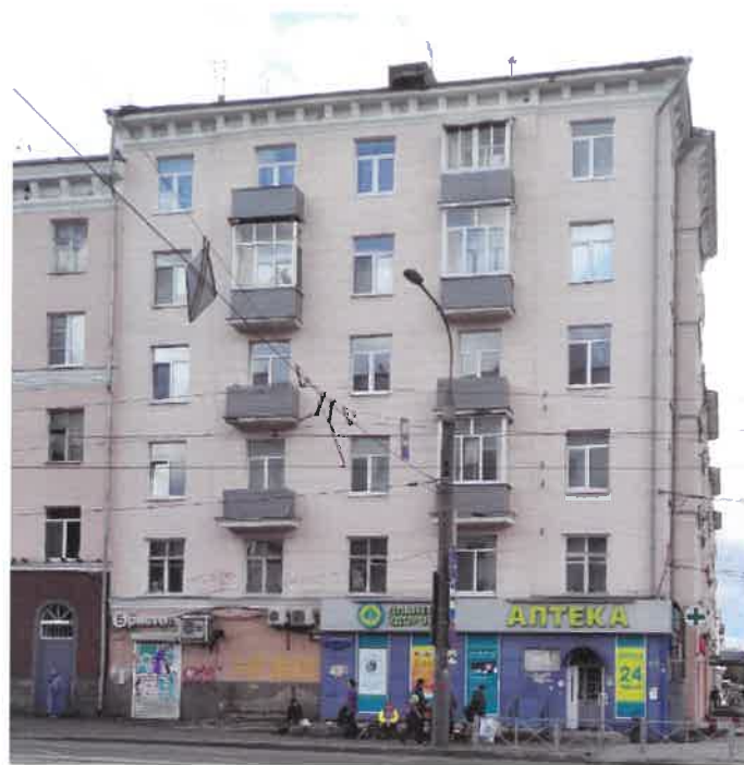
Существующее состояние бокового фасада (фотофиксация)
