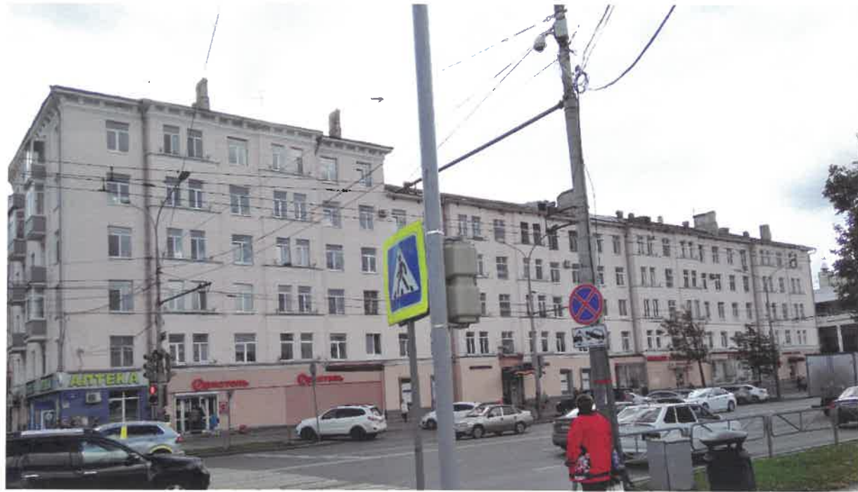
Существующее состояние главного фасада (фотофиксация)
