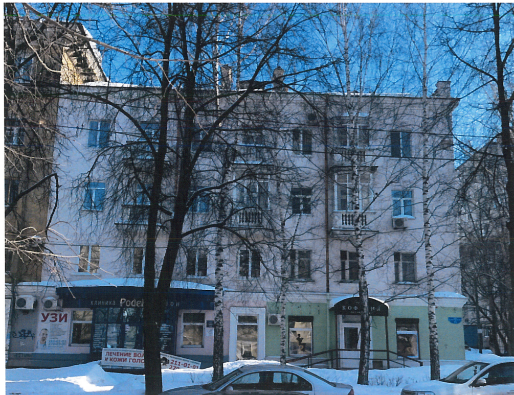
Существующее состояние главного фасада (фотофиксация).
