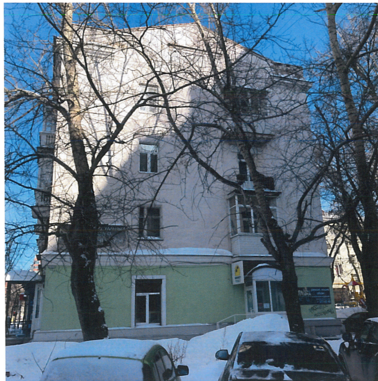
Существующее боковых фасадов (фотофиксация).
