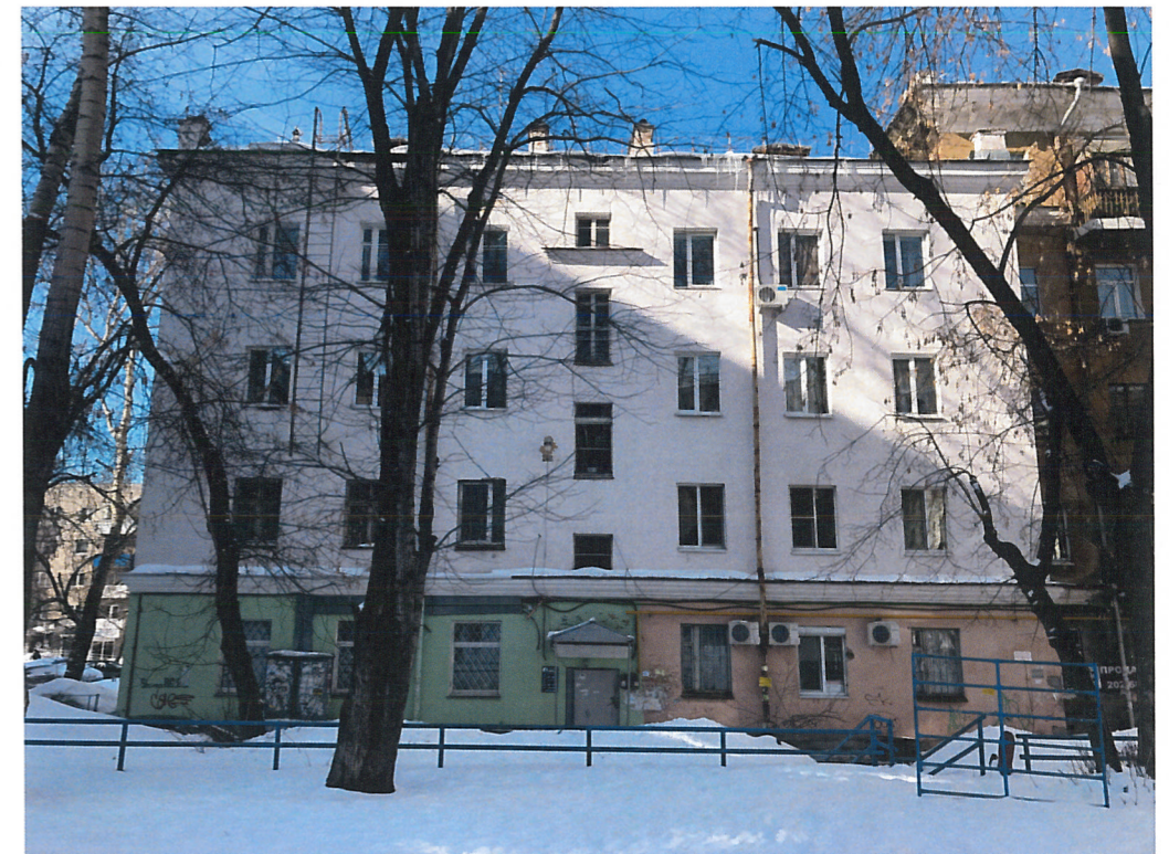
Существующее состояние дворового фасада (фотофиксация).
