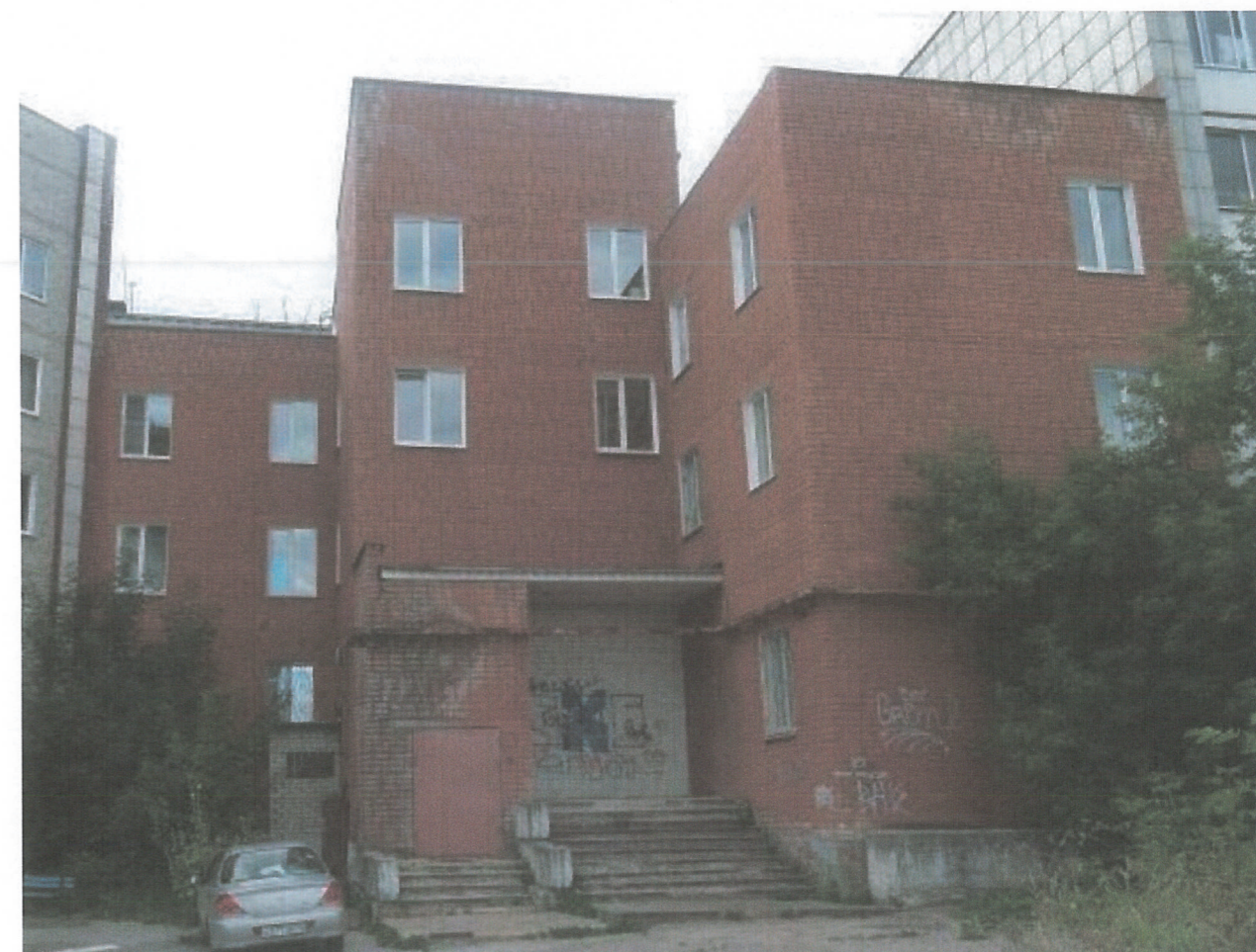
Существующее состояние фасадов (фотофиксация) Дворовой фасад
