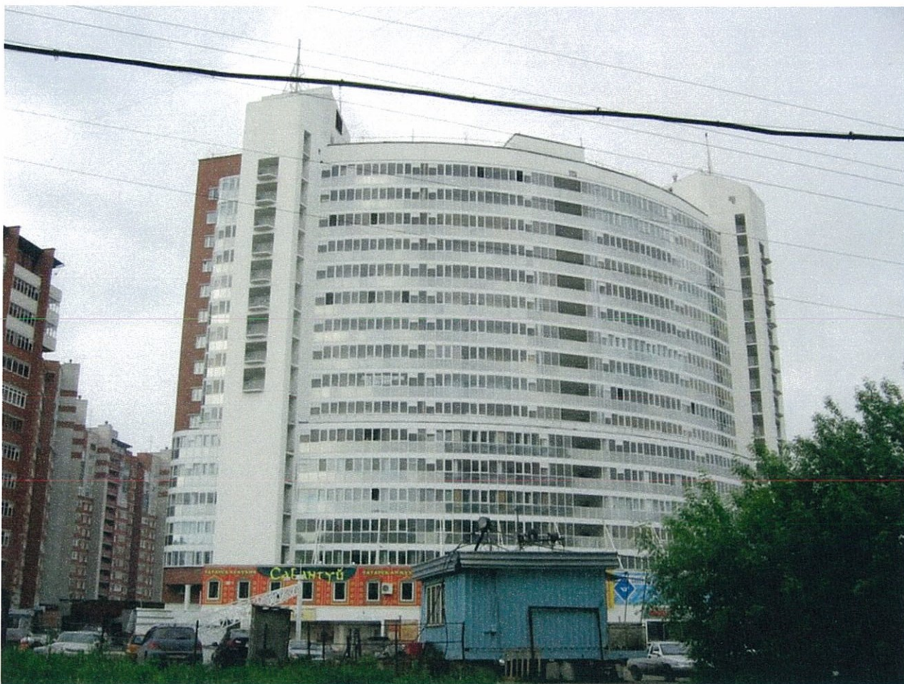
Существующее состояние бокового фасада (фотофиксация).
