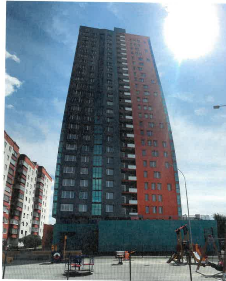
Существующее состояние дворового фасада (фотофиксация).
