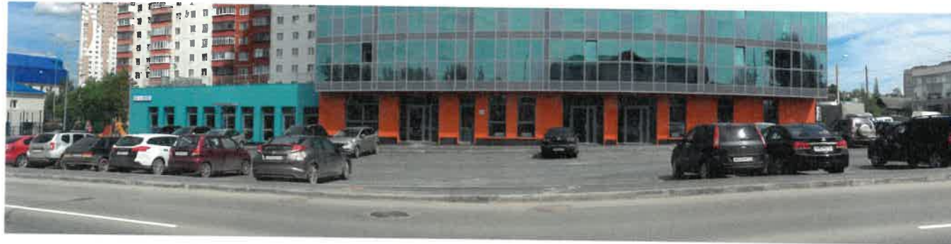
Существующее состояние главного фасада (фотофиксация).
