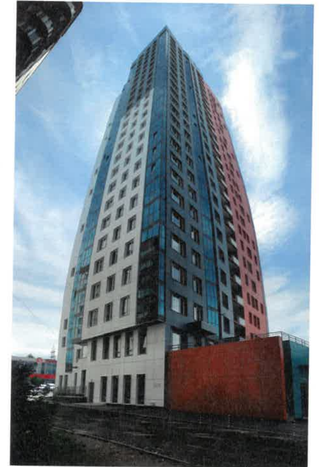
Существующее состояние бокового фасада (фотофиксация).
