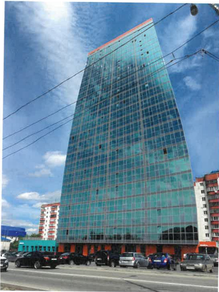
Существующее состояние главного фасада (фотофиксация).
