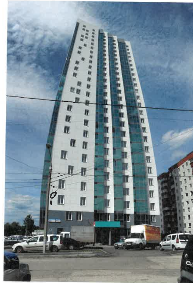
Существующее состояние бокового фасада (фотофиксация).
