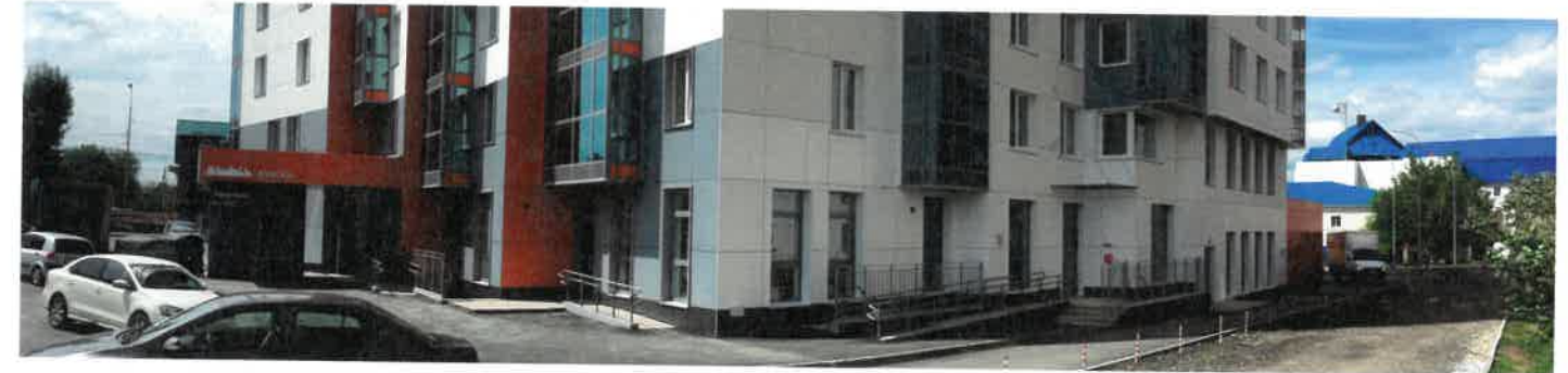
Существующее состояние бокового фасада (фотофиксация).
