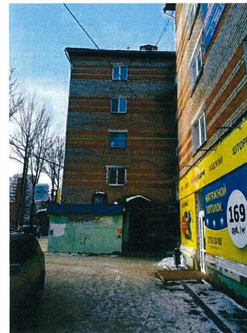
Существующее состояние бокового фасада (фотофиксация).
