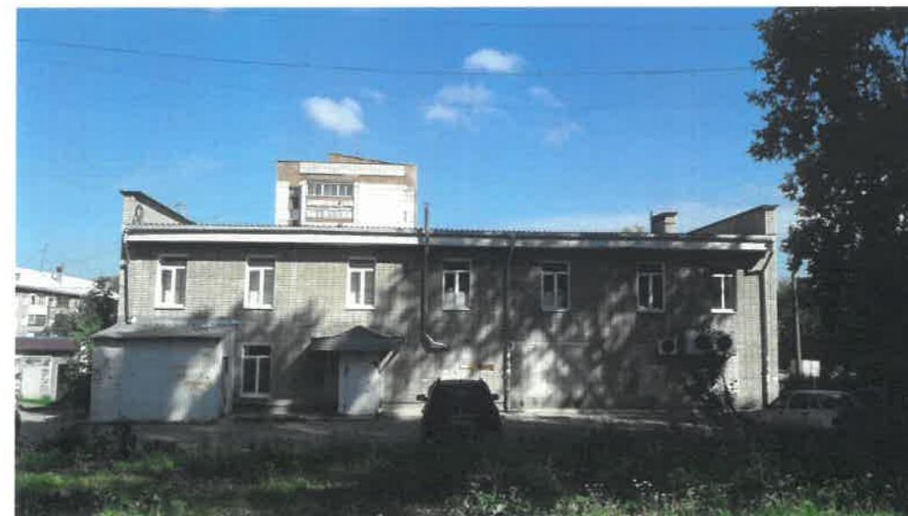
Существующее состояние дворового фасада
