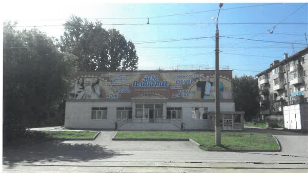
Существующее состояние главного фасада
