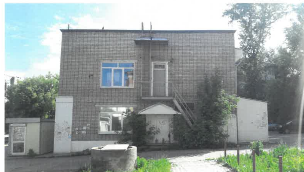
Существующее состояние бокового фасада
