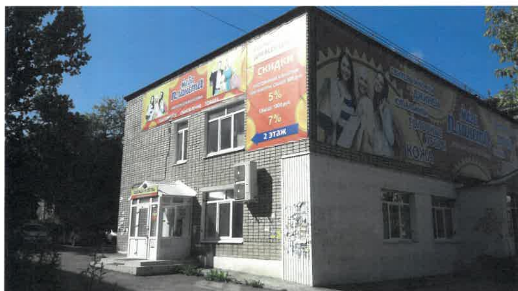
Существующее состояние бокового фасада
