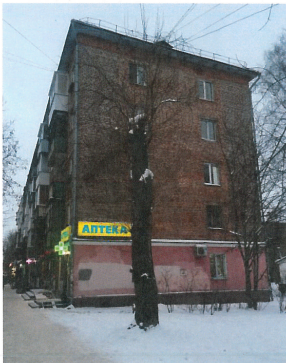
Существующее состояние бокового фасада (фотофиксация).
