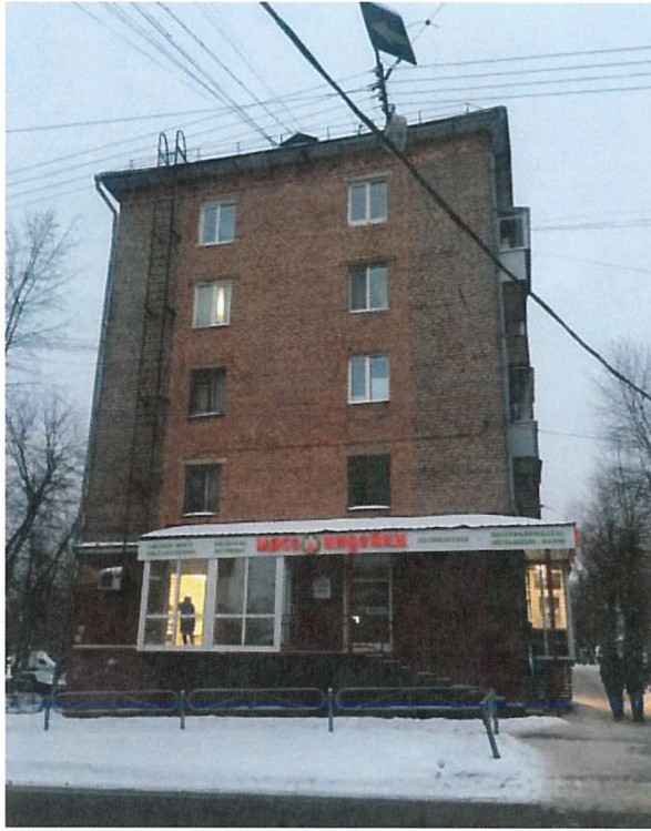
Существующее состояние бокового фасада (фотофиксация).
