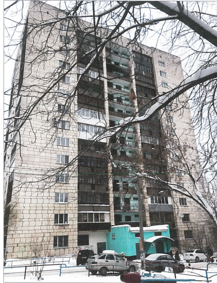
Дворовый фасад (существующее положение)
