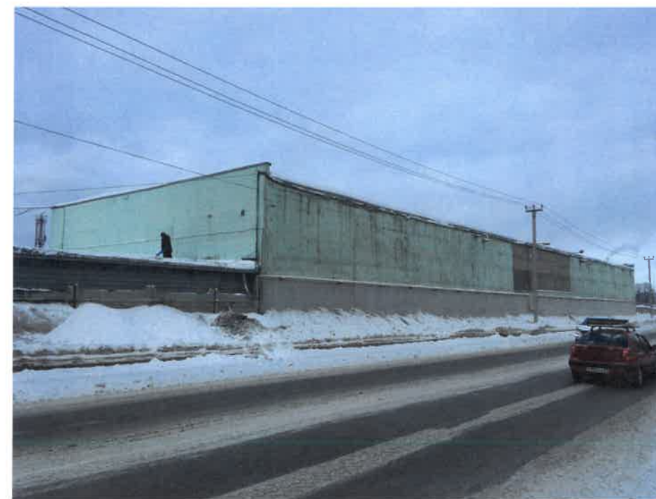
Существующее состояние главного фасада (фотофиксация).
