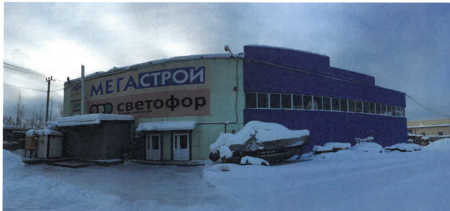
Существующее состояние бокового фасада (фотофиксация).
