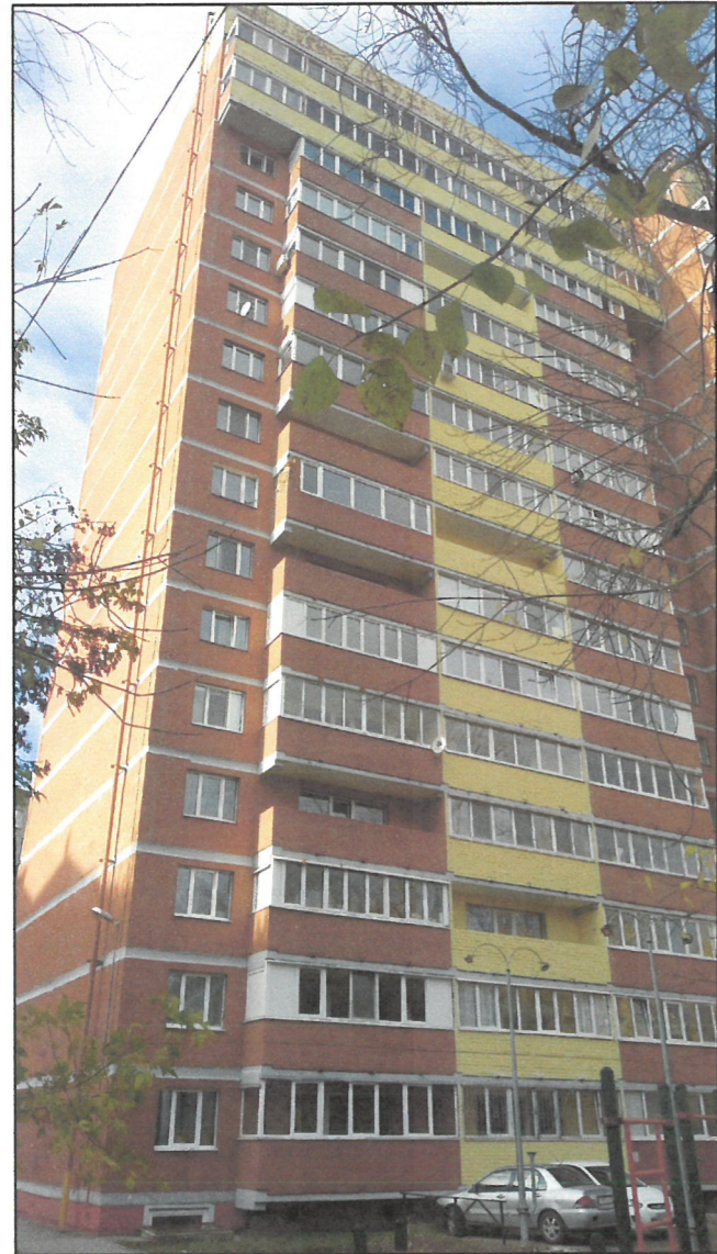
Главный фасад (фотофиксация части фасада)
