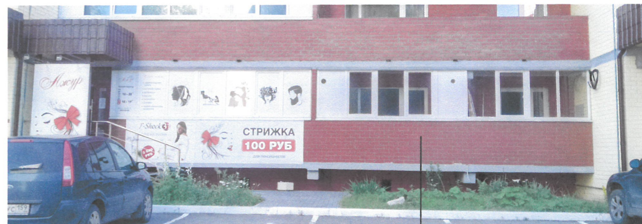
Дворовой фасад (фотофиксация в осях 1-5)
