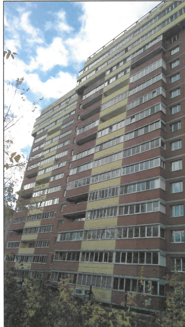
Главный фасад (фотофиксация части фасада)
