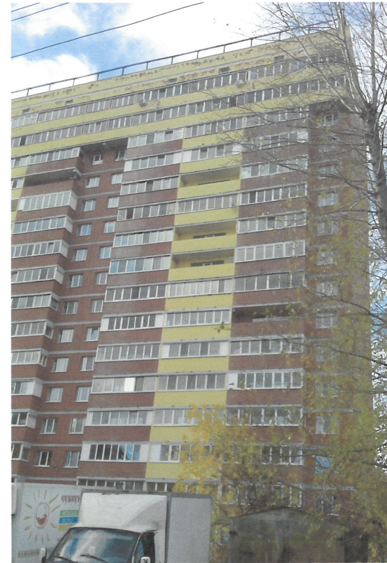
Главный фасад (фотофиксация части фасада)
