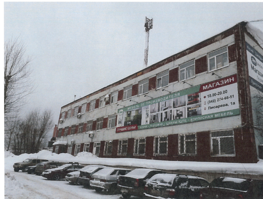
Главный фасад (фотофиксация).
