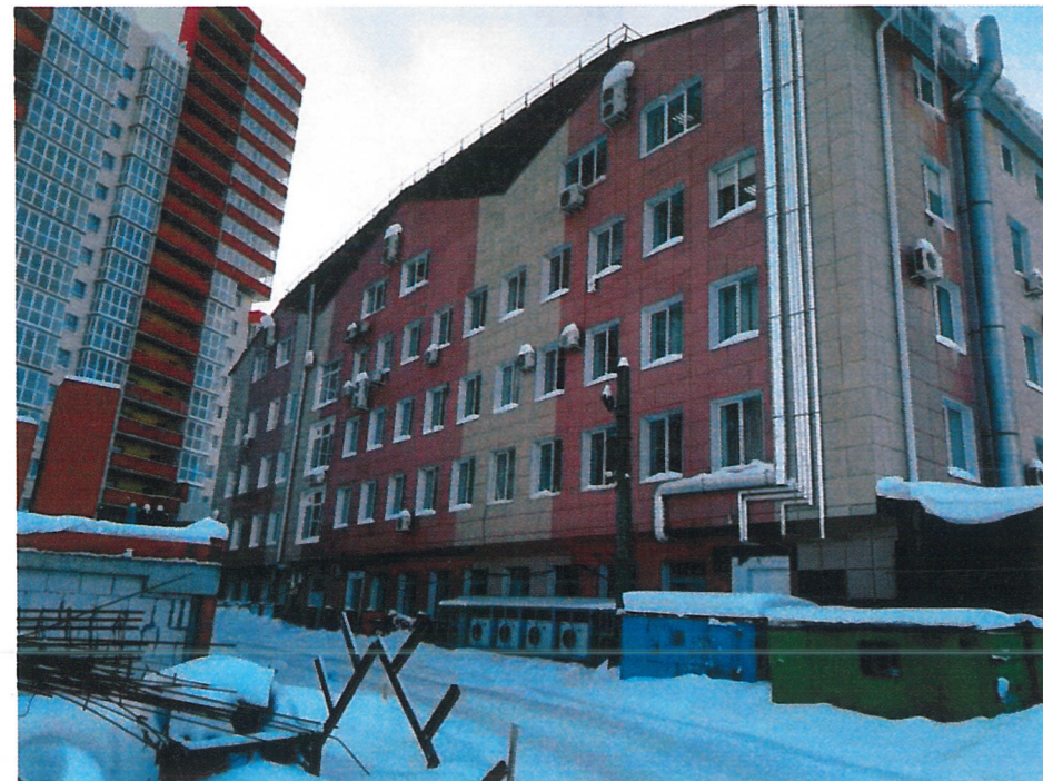
Фотофиксация существующего фасада по осям Б-1-2
