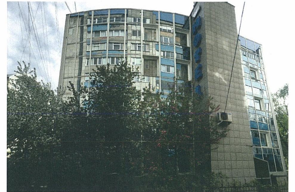
Существующее состояние бокового фасада (фотофиксация).
