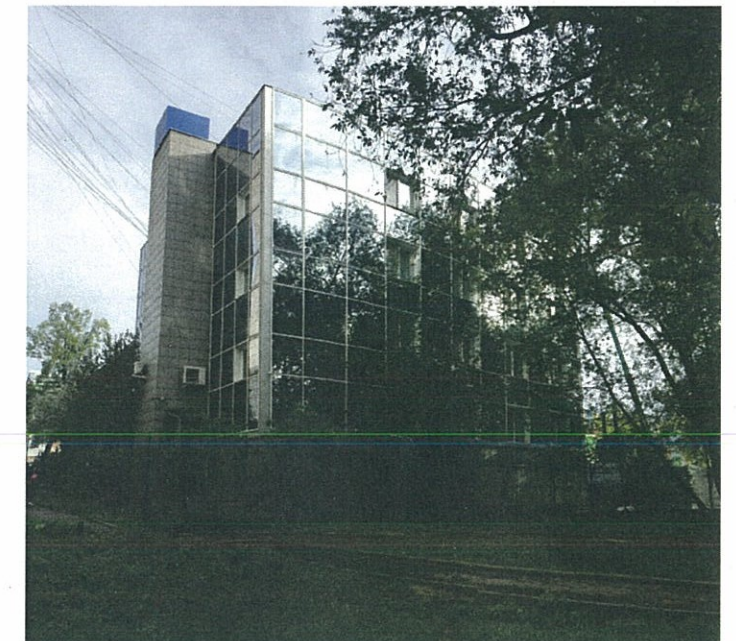
Существующее состояние дворового фасада (фотофиксация).
