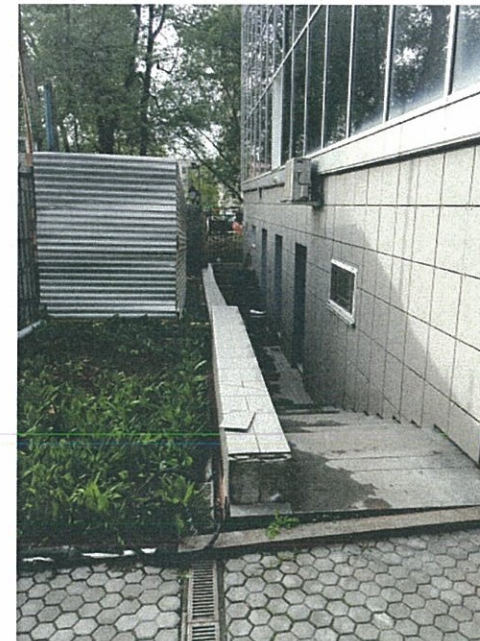
Существующее состояние бокового фасада (фотофиксация).
