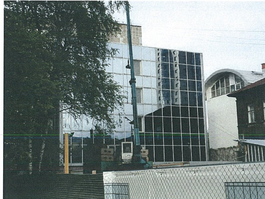
Существующее состояние бокового фасада (фотофиксация).
