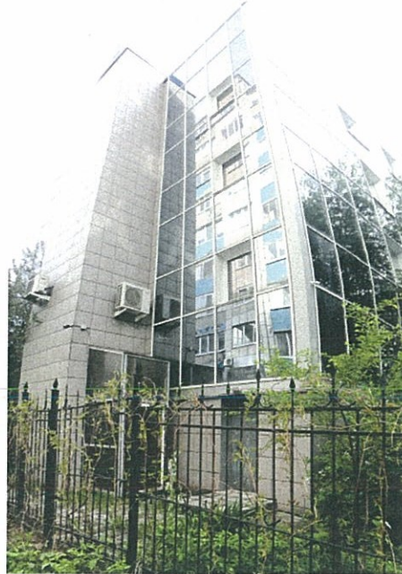
Существующее состояние бокового фасада (фотофиксация).
