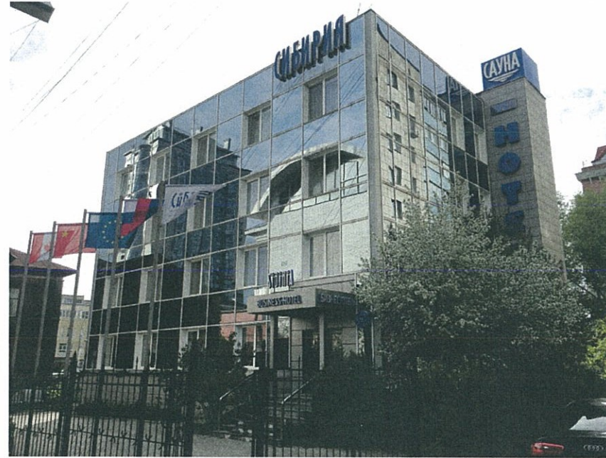
Существующее состояние главного фасада (фотофиксация).
