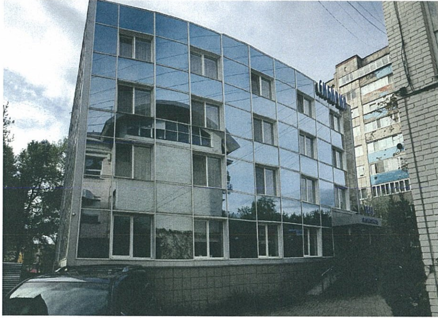
Существующее состояние главного фасада (фотофиксация).
